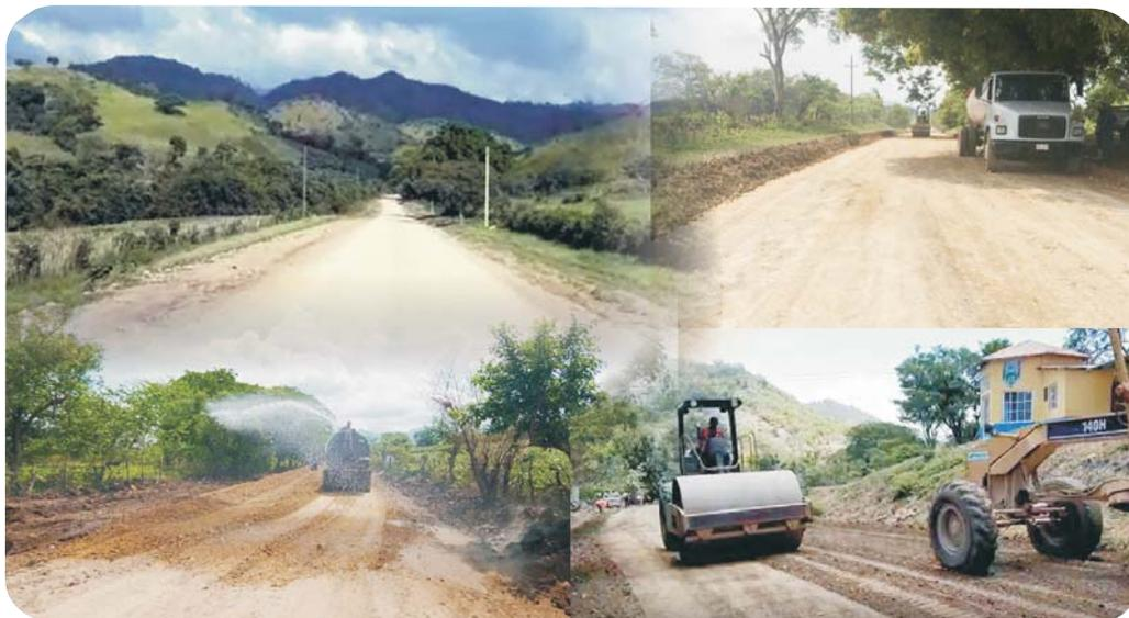
Obras como afinamiento, colocación de material selecto y balastado se realizan en los tramos.
