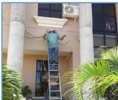
Trabajos de Mantenimiento de Aires acondicionados.
