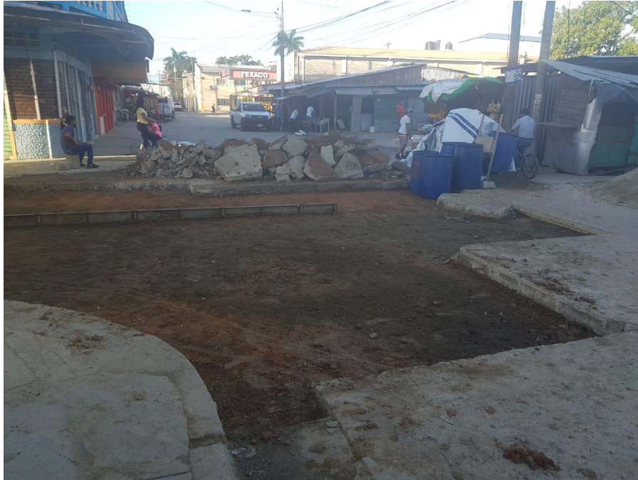
Ilustracion5. Demolicion y compactacion de material selecto nuevo.
