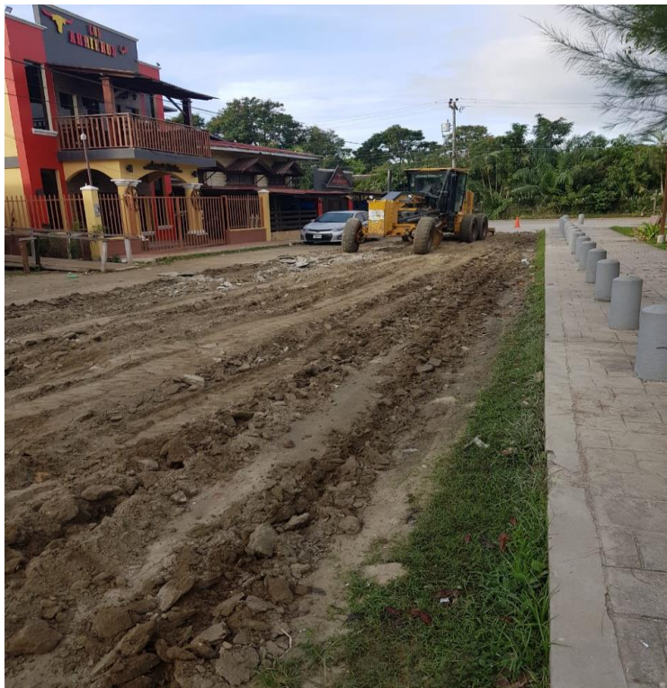
Ilustracion2. Trabajos de corte de material sobrante.
