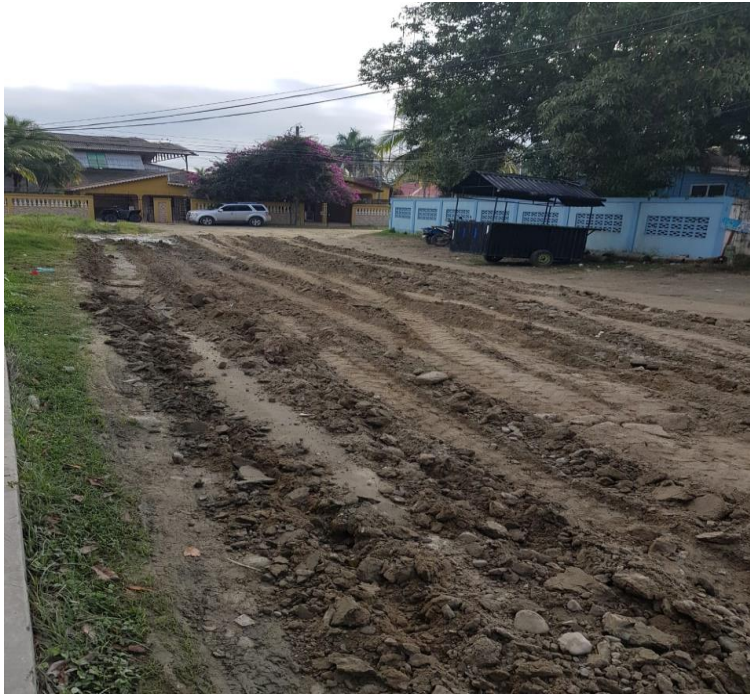
Ilustracion1. Remocion de material sobrante.
