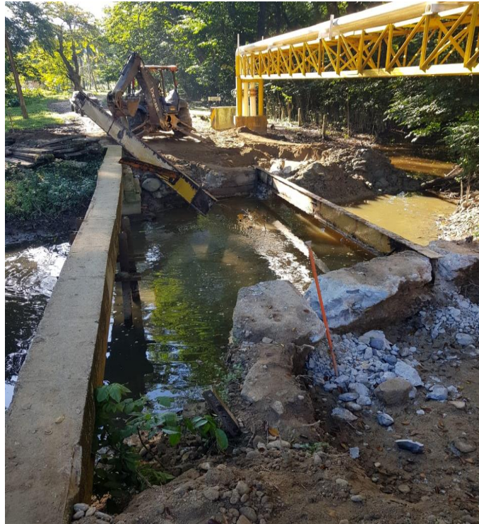
Ilustracion4. Extraccion de vigas H existentes.
