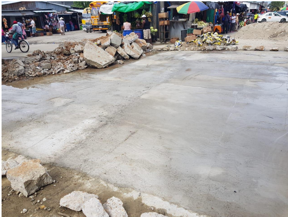
Ilustracion6. Fundicion de losa de concreto hidraulico Nueva.
