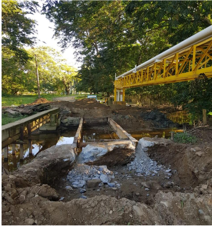
Ilustracion3. Demolision de estructura existente.
