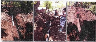
Alcantarillado Sanitario de Barrio La Torre
