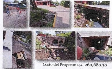
Construcción de Cajas Puentes B° Buenos Aires
