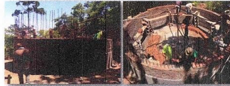
Construcción de Tanque de Agua potable
