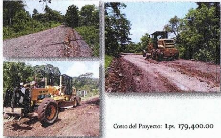
Reparación de Calle desde San Francisco a Quebradas de Agua
