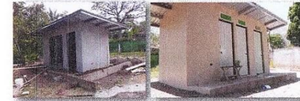
Construcción de Servicios Sanitarios en Balneario Público en la Colonia Aurora
