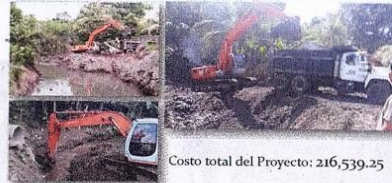
Dragado pertinente y preventivo de Quebrada San Simión en la Colonia La Paz
