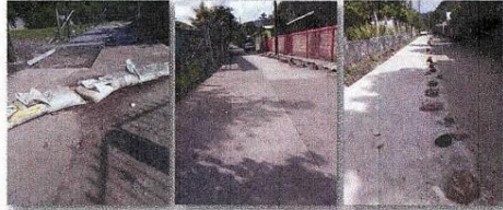
Pavimentación de Calle en Barrio los Laureles, Cañaveral
