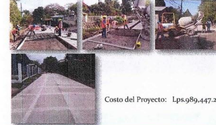
Pavimentación de 135 Mts Líneales de Calle en el Bº Buenos Aires
