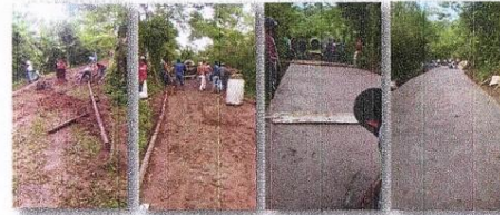
Pavimentación de Calle en el Barrio el Centro de la Virtud
