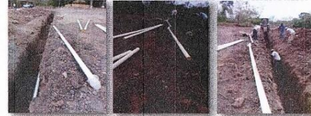
Mejoramiento de Alcantarillado Sanitario en La Química
