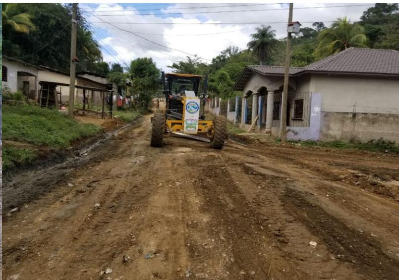
Se aprecia en la gráfica los trabajos de la maquinaria en la conformación cuneteo de calles de los Tangos
