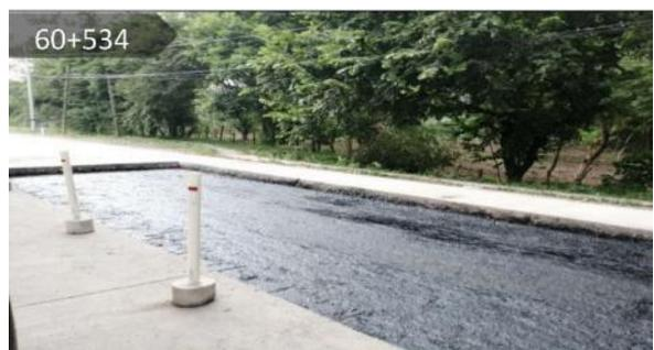
Imprimación con emulsión asfáltica previo a la fundición.
