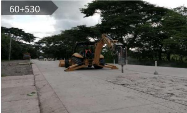
Demolición de losas de concreto agrietadas
