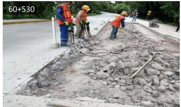
Demolición de losas de concreto agrietadas
