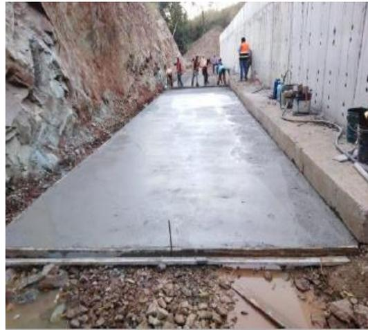
Panorámica de los trabajos de colado de concreto hidráulico en calzada LI.
