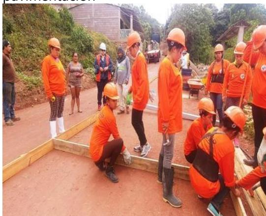
Mujeres preparando el encofrado para fundición del concreto
