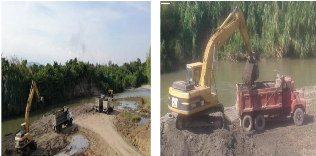
Corte y carga de material de canalización
