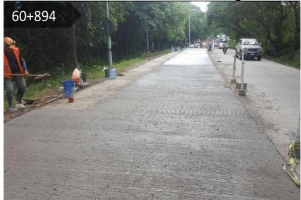
Fundición de con concreto hidráulico
