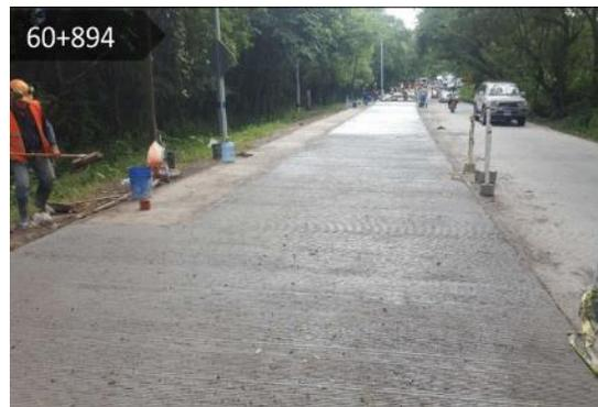
Fundición con Concreto Hidráulico
