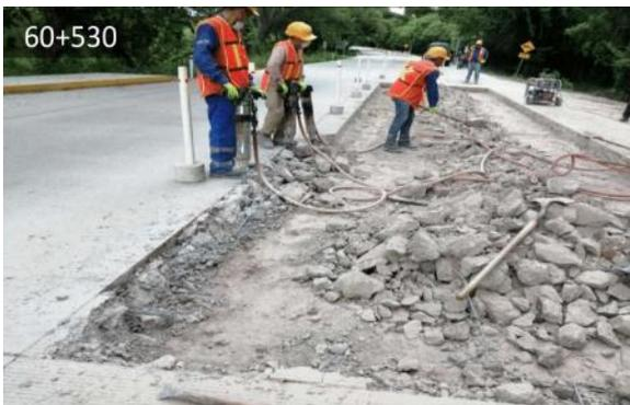
Demolición de losas de concreto agrietadas
