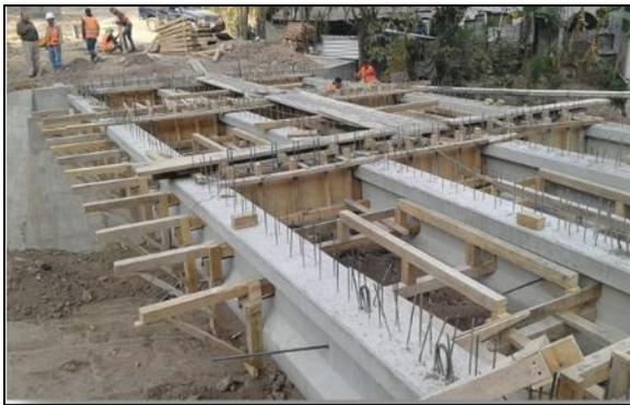
Se trabajó en la colocación de vigas pretensadas tipo I-90 de 16.24 ml de longitud, encofrados de losa, armados de losa de rodadura, construcción de gaviones en estribo No.1.
