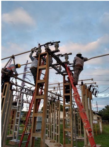
Mantenimiento Mayor a los Reguladores de Voltaje Bajo Carla (OLTC) de los Transformadores T603 Y T604 En Subestación Progreso, para garantizar calidad del servicio y confiabilidad en la operación.
