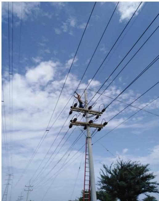
Reparación por falla en Línea De Transmisión de 69 kV Guaimaca - Juticalpa L442
