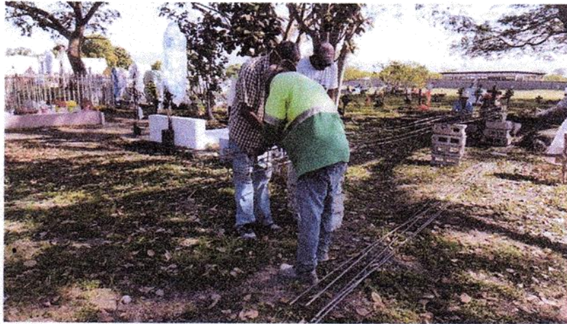
Cimentación de mampostería
