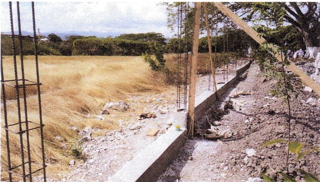
Fundición de solera inferior
