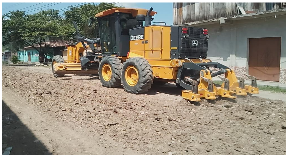
Se visualiza la maquinaria realizando trabajos de escarificación en lo conformación de calle
