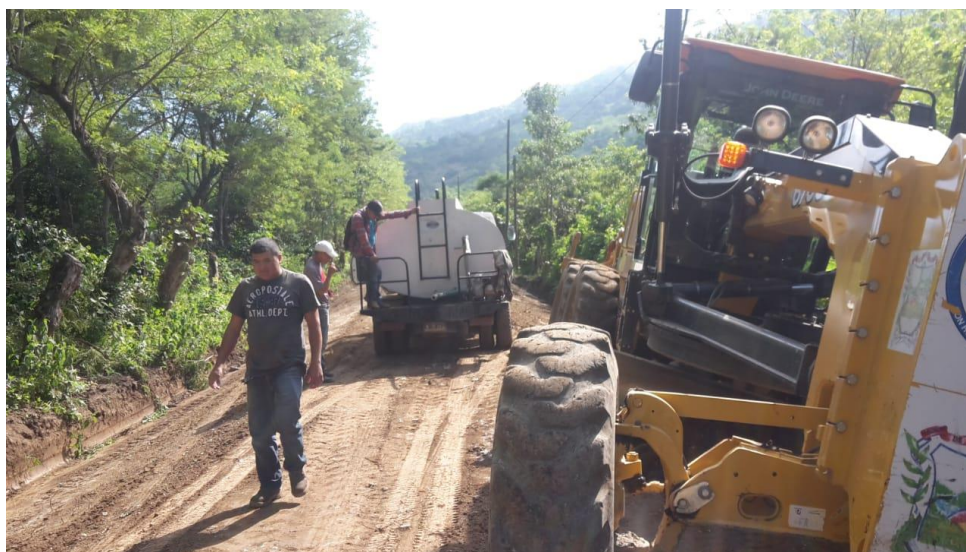
Se visualiza la maquina trabajando en la conformación de calle y cuneteo
