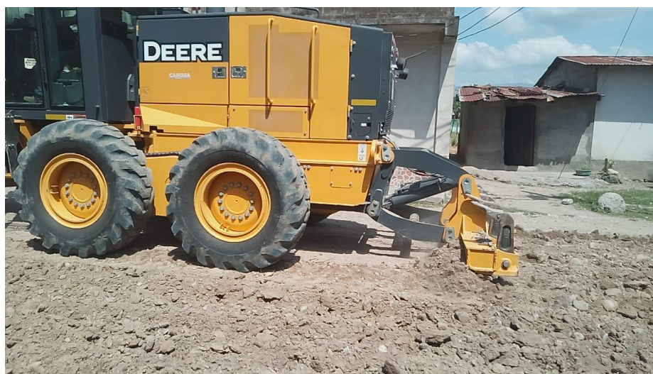
Preparación de calle en su escarificación para afirmar con un tendido luego vibrar.
