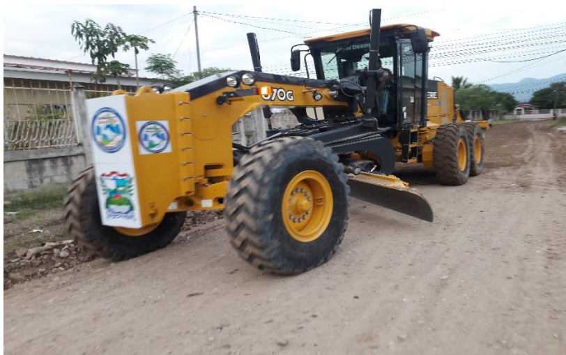
Se visualiza la maquinaria trabajando con eficiencia dejando las calles en óptimas condiciones.
