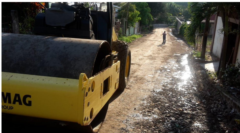
Trabajos de Vibrado de calle para una mejor vida a la misma
