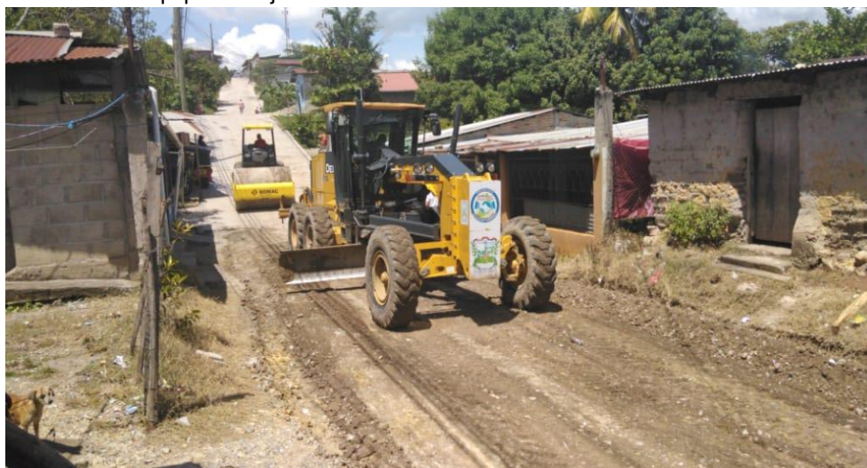
Maquinaria realizando trabajos de conformación de calles y vibrado
