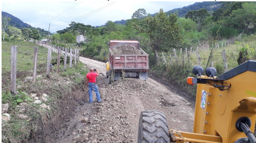
La maquinaria en la preparación de la calle de Quebrada Seca
