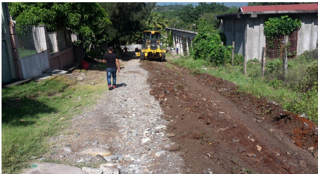
Las vías de acceso son reparadas constantemente con equipo municipal.
