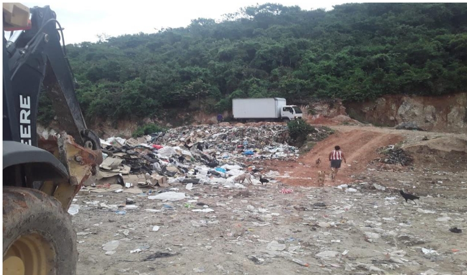
Se visualiza El área de trabajo del relleno sanitario municipal
