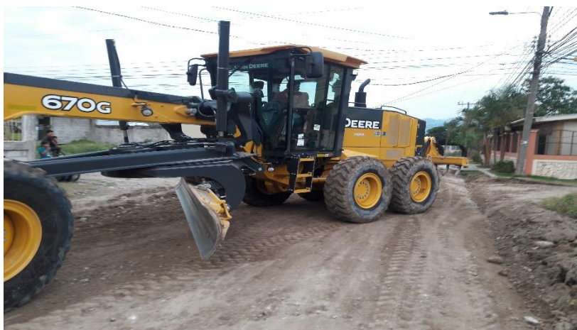
Maquinaria Municipal en reparación de las calles de este barrio con calidad de obra.
