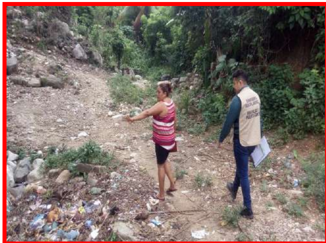
Revisión de Quebrada en la comunidad de Brisas de Baracoa
