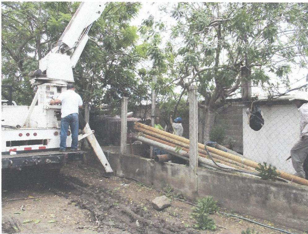
4. Reparar tubería de 6" en línea de impulsión de Pozo Colinas de Suiza.
