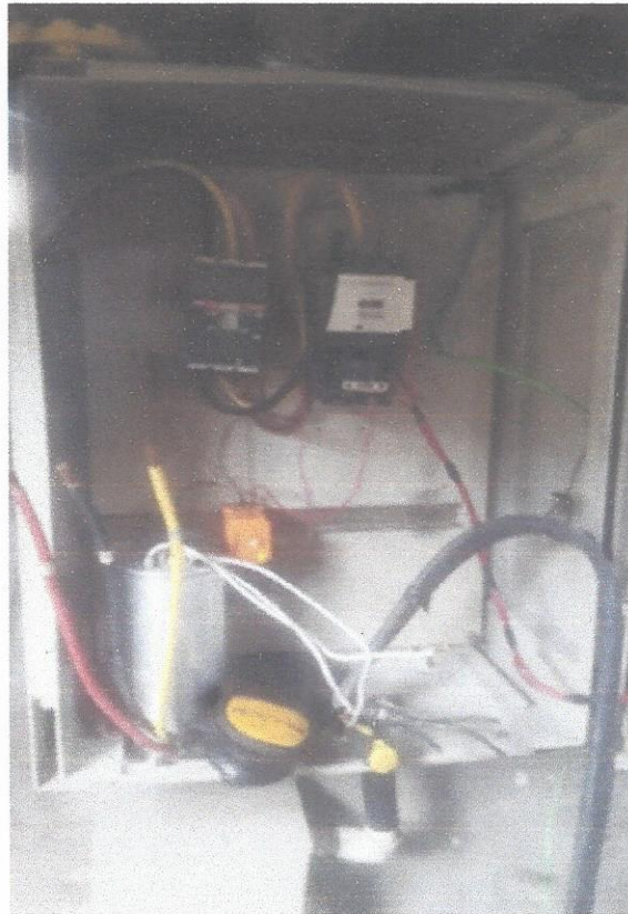
15. Electromecánica cambio de capsula capacitadora en pozo de Brisas del Calan.
