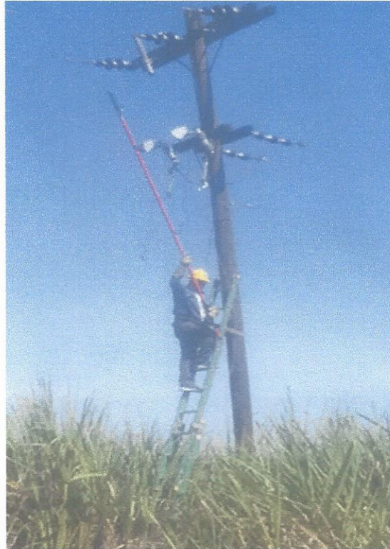
16. Cambio de cajas cortacircuito en pozo de Linsa Dos Caminos.
