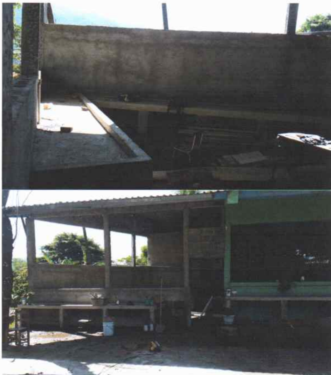
construcción de cocina en Escuela El Almendro
