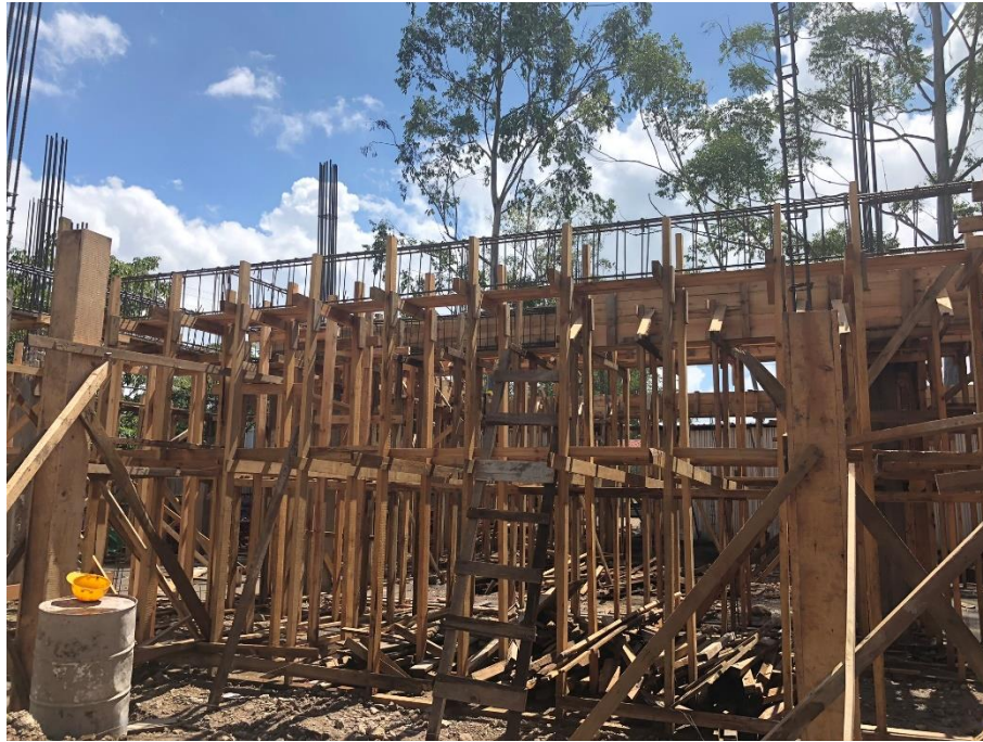
Imagen 1. Piloteado de Vigas
