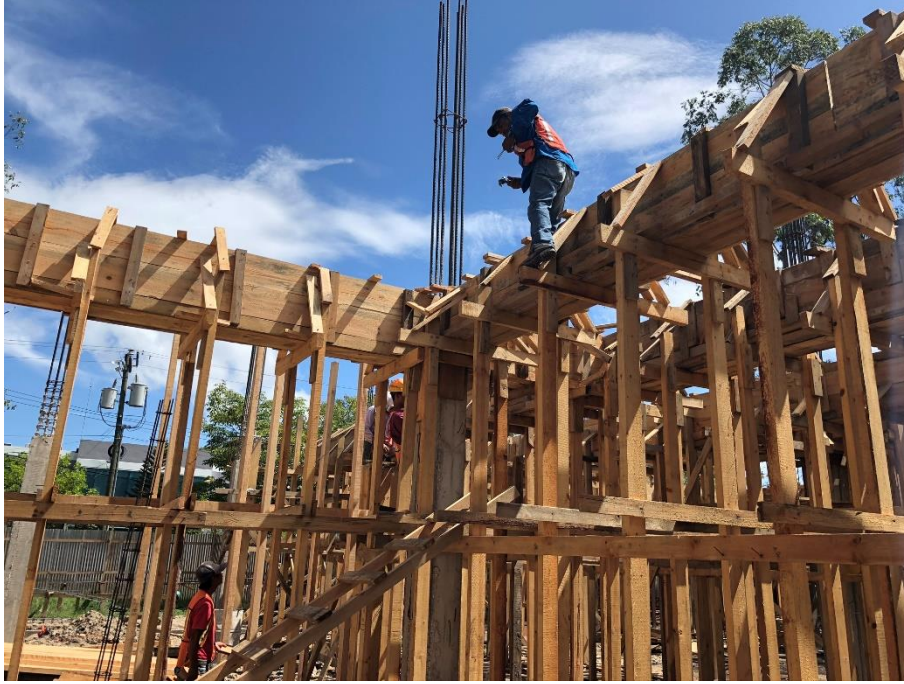
Imagen 3. Encofrado de Vigas
