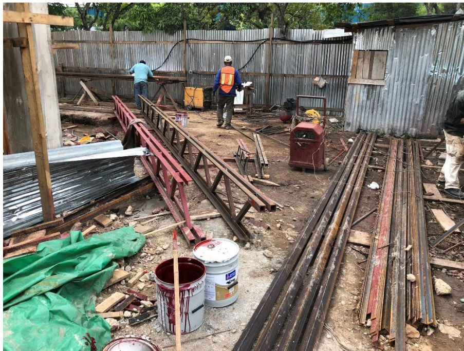
Imagen 6. Soldadura de Joists
