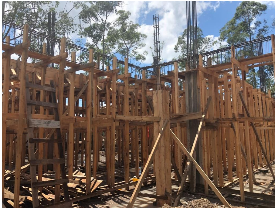
Imagen 2. Armado de Vigas
