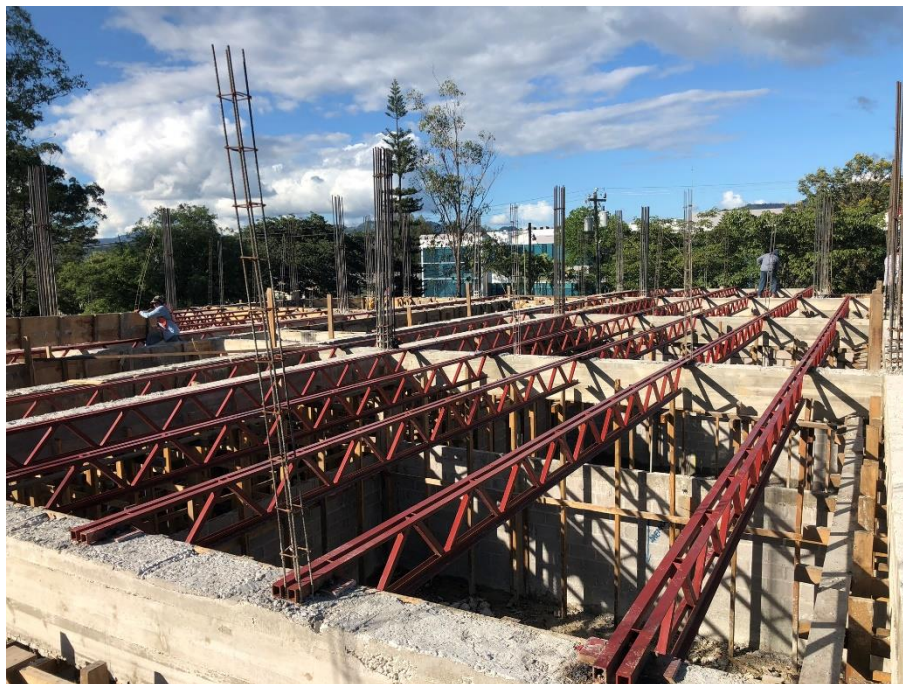
Imagen 8. Joist de entepiso instalados
