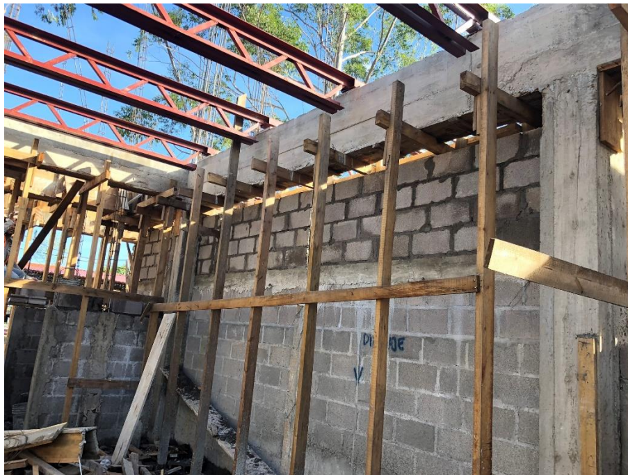
Imagen 9. Levantamiento de paredes de bloque
