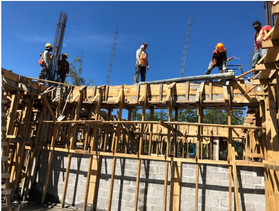
Imagen 4. Fundición de Vigas
