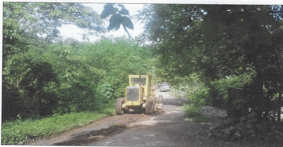
Reparación de calle en la comunidad del higo sector Marañón
