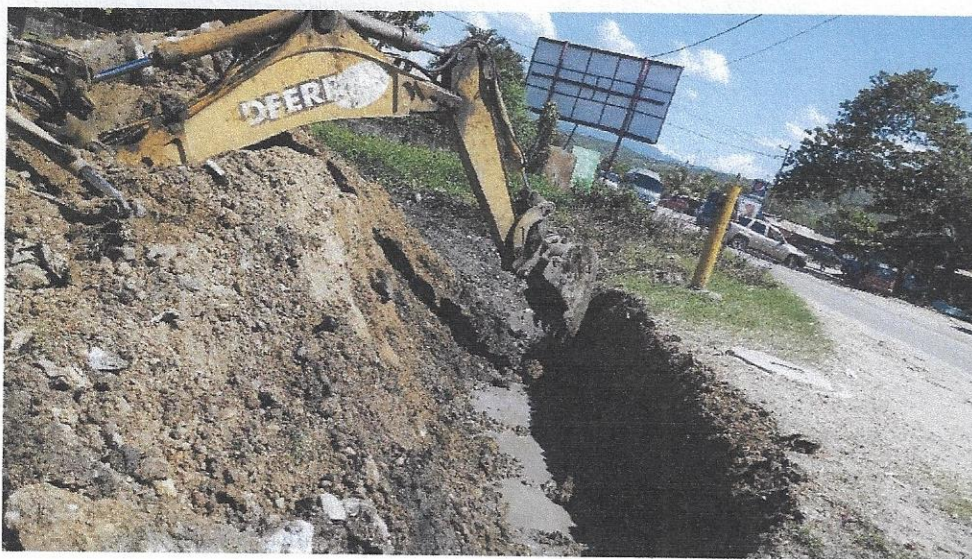
Reparación de cunetas en el Sector Este A
