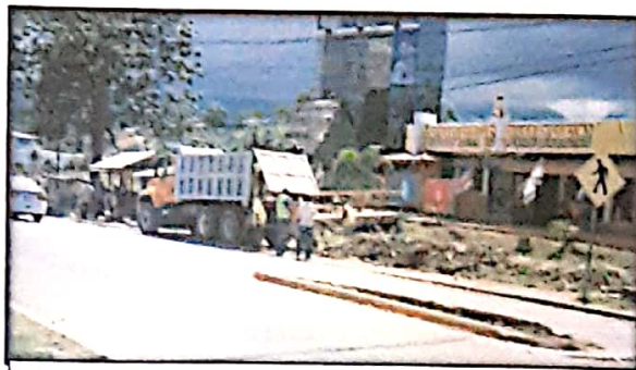
Limpieza de canales de agua y alcantarillado
