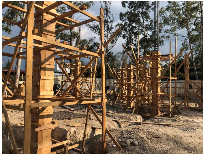
Imagen 6. Encofrado de Columnas
