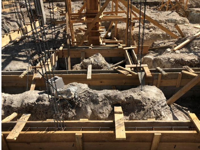
Imagen 4. Armado de Solera Inferior
