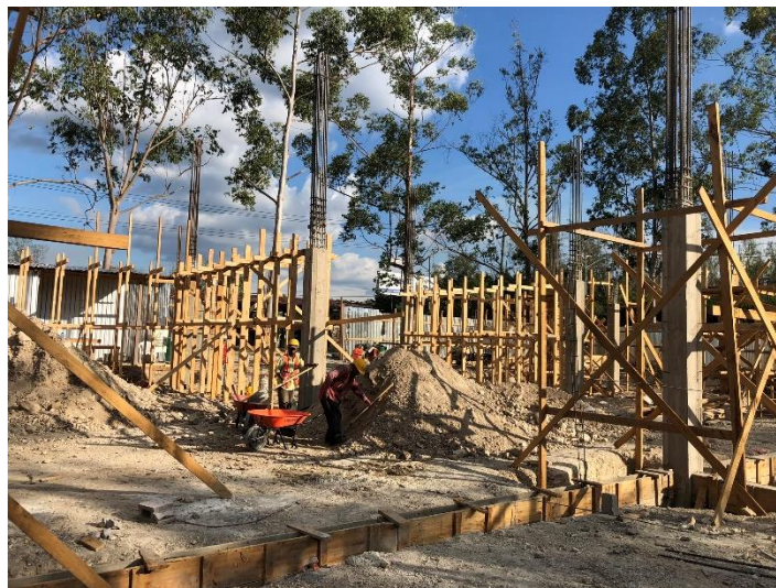
Imagen 8. Piloteado de Vigas
