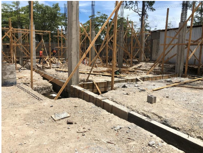
Imagen 5. Fundición de Solera Inferior
