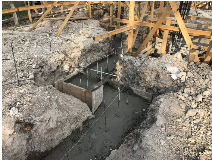
Imagen 2. Fundición de Zapatas Corridas
