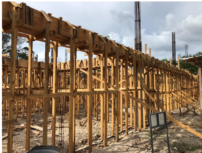
Imagen 10. Encofrado de Vigas
