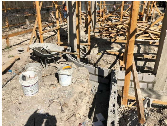
Imagen 3. Sobrecimentación de Bloque
