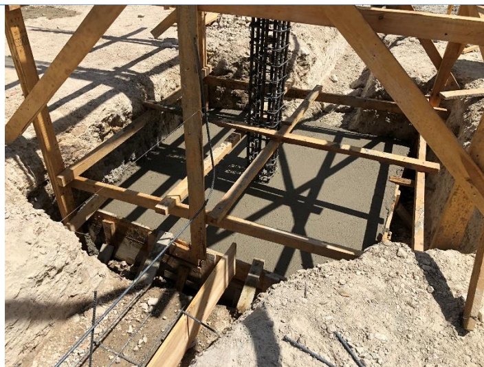
Imagen 1. Fundición de Zapatas Aisladas
