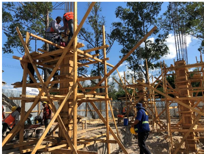
Imagen 7. Fundición de Columnas
