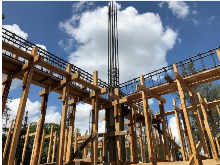
Imagen 9. Armado de Vigas
