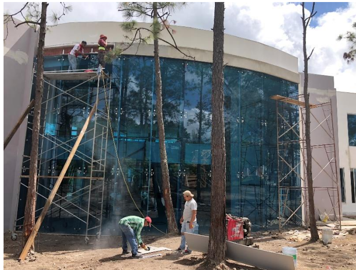
Imagen 6. Instalación de Muro Cortina Araña
