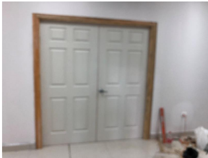
Imagen 3. Instalación de Puertas Dobles
