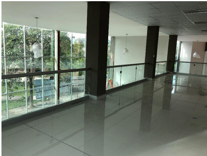
Imagen 8. Instalación de Barandales
