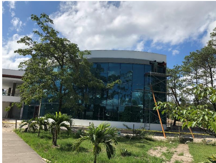
Imagen 1. Instalación de Forro de Durock
