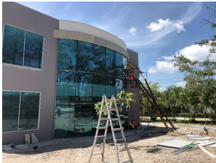
Imagen 5. Instalación de Muro Cortina Modular
