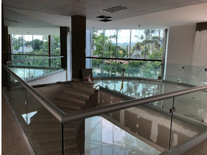
Imagen 7. Instalación de Barandales
