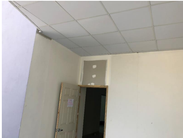
Imagen 4. Instalación de Puertas Sencillas
