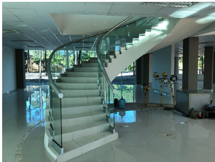
Imagen 6. Instalación de Barandales en Gradas de Caracol
