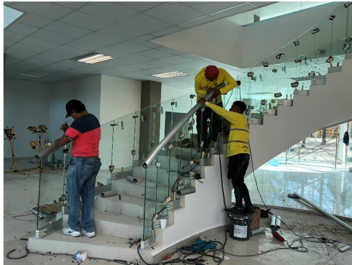
Imagen 5. Instalación de Barandales en Gradas de Caracol
