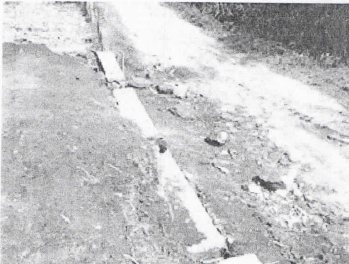
CIMENTACIÓN Y EXCAVACIÓN PARA INSTALACIÓN DE TUBERÍA DE AGUA POTABLE PARA LOS SERVICIOS SANITARIOS
