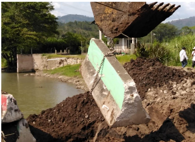
Se visualiza el movimiento de la maquinaria en la construcción de la protección de la toma de agua
