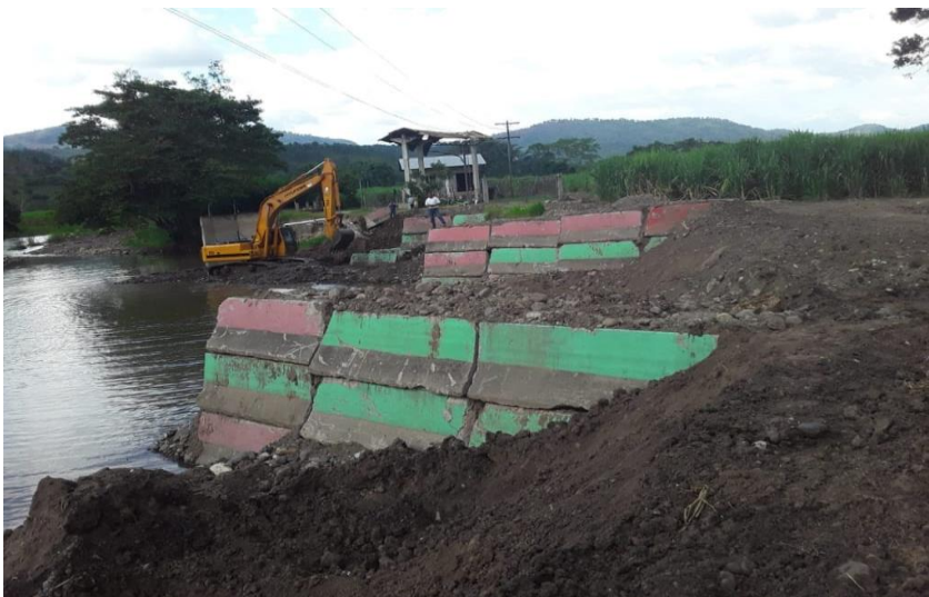
Muy avanzados los trabajos en la instalación de los espigones de concreto en toma de agua del Rio Chamelecón
