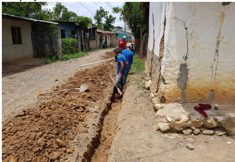
Se visualiza el avance del proyecto en excavación para la instalación de la tubería en la comunidad de Santa Luz
