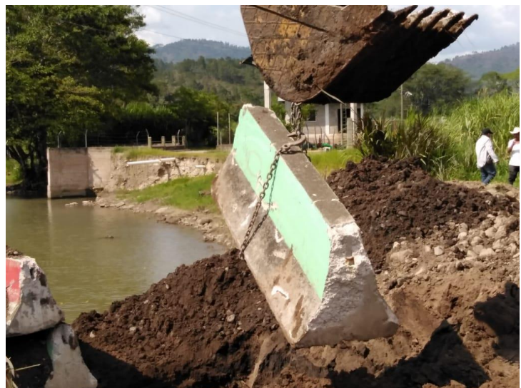
Muy avanzados los trabajos en la instalación de los espigones de concreto en toma de agua del Rio Chamelecón
