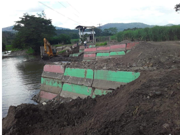
Muy avanzados los trabajos en la instalación de los espigones de concreto en toma de agua del Rio Chamelecón
