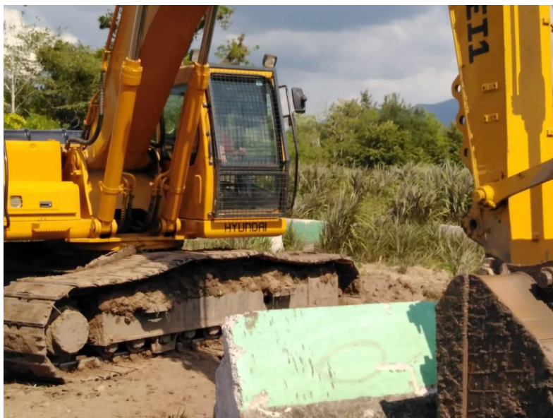
Los espigones o barreras yersi vendrán a dar una protección a la toma de agua y con esto un mejor servicio al sistema de agua, ya que la instalación de la bomba de agua es de mucho valor y se necesita protección
