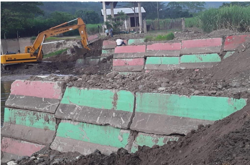
Muy avanzados los trabajos en la instalación de los espigones de concreto en toma de agua del Rio Chamelecón
