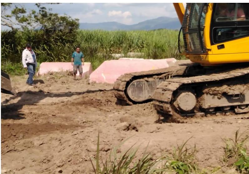
Se visualiza el movimiento de la maquinaria en la construcción de la protección de la toma de agua
