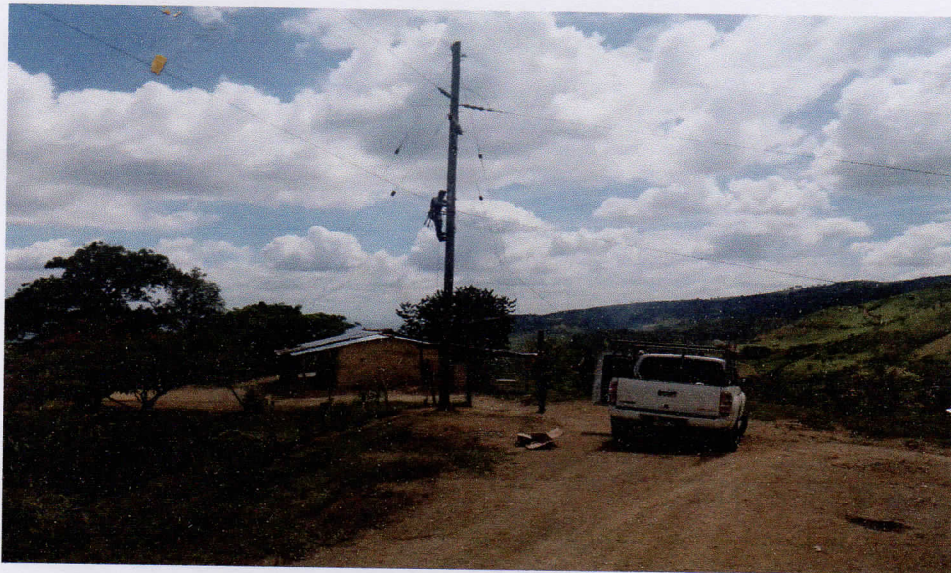
Electrificación barrio abajo mina onda
