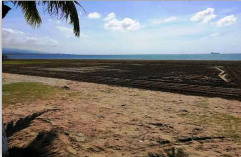
Acondicionamiento del terreno, realizado por el Departamento Municipal de Mantenimiento Vial
