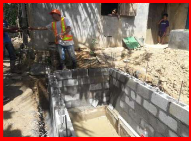
Construcción de Letrinas, Aldea Rio Arriba
