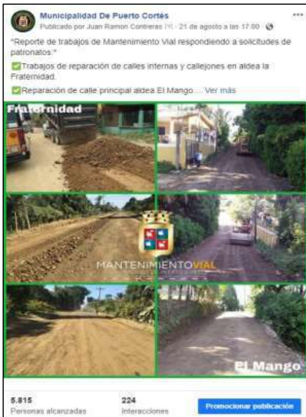
Trabajos de Mantenimiento vial
