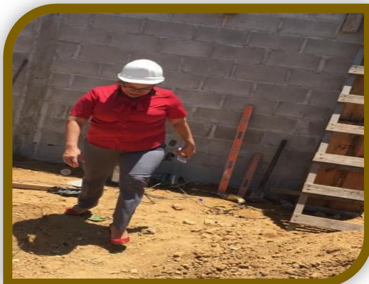
La jefatura de Programas Sociales Visita A la construcción de la escuela Municipal Especial Emanuel, para observar los avances logrados
