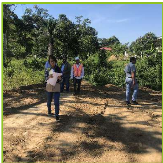
Proyecto Urbanización “Porto Belo”
