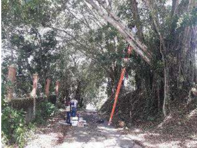
Instalación de lámparas en Brisas del Mar Sector El Porvenir
