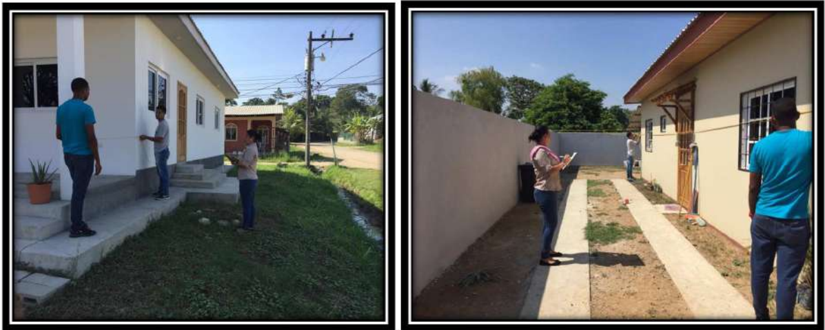
EVALUACION DE EDIFICACIONES
