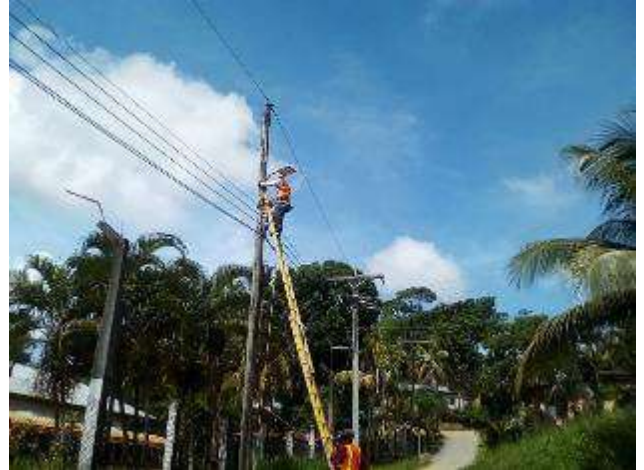
Instalación de lámparas de algunas colonias del Sector, El Chile
