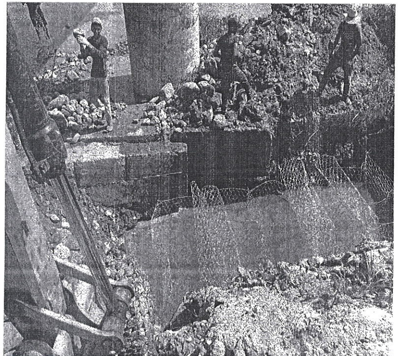
Reparación de gavión caja en presa N. 1
