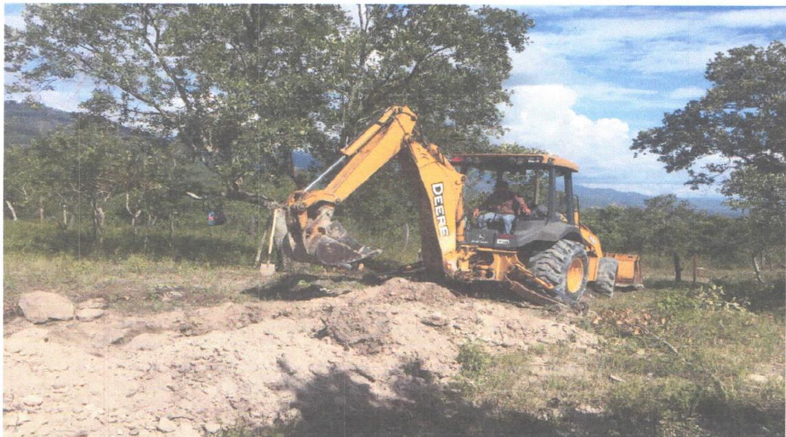
Supervisión de la excavación realizada por la retro excavadora, de línea de distribución del reservorio del Porvenir
