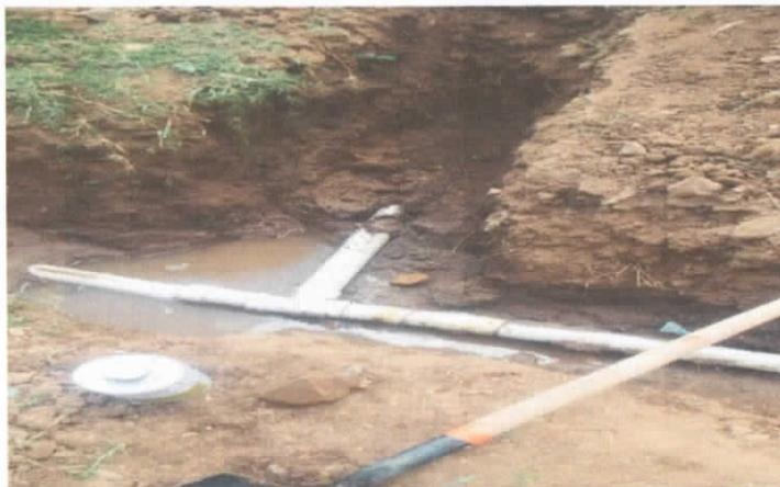
INSPECCION DE VALVULAS TUBERIA MADRE CONDUCE HACIA EL TANQUE
