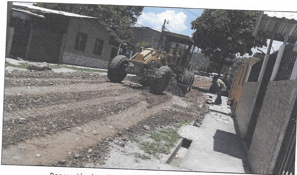
Reparación de calles colonia Independencia, Sector Este A
