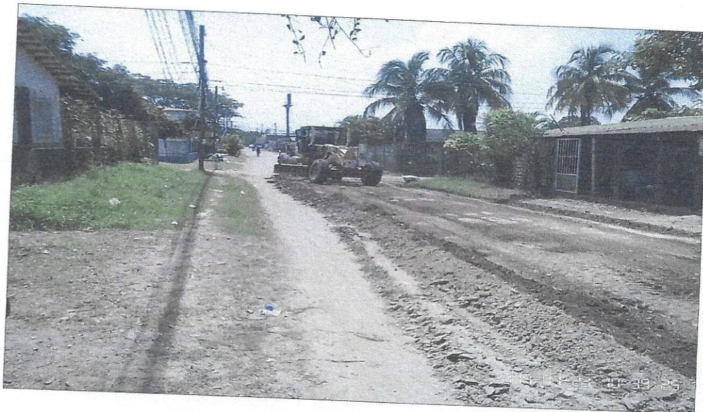
Reparación de calles Barrio Suyapa, Sector Oeste B
