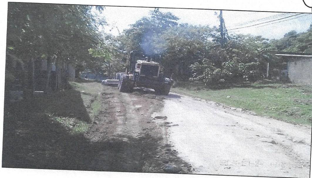
Reparación de calles Colonia Orquídea II, Sector Oeste B
