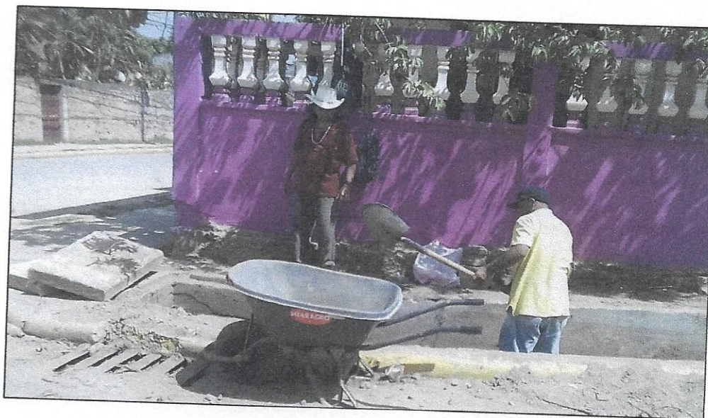
Limpieza de cunetas Barrio La Flores, Sector Oeste B
