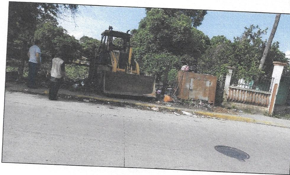
Eliminación de basureros clandestinos, Sector Este A Emergencia de Dengue
