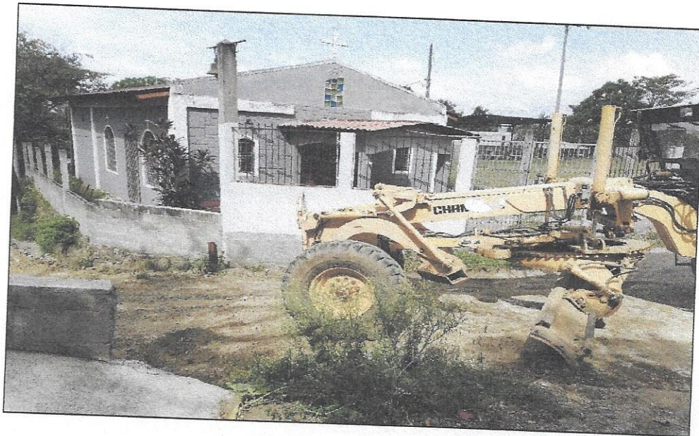
Reparación de calles Nuevo Chamelecón, Sector Norte
