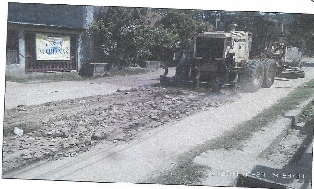
Reparación de calles y cuneteo, Barrio Las Flores Sector Oeste B
