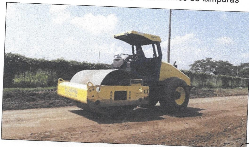
Reparación y ampliación de calles Colonia Primero de Mayo, Sector Oeste C
