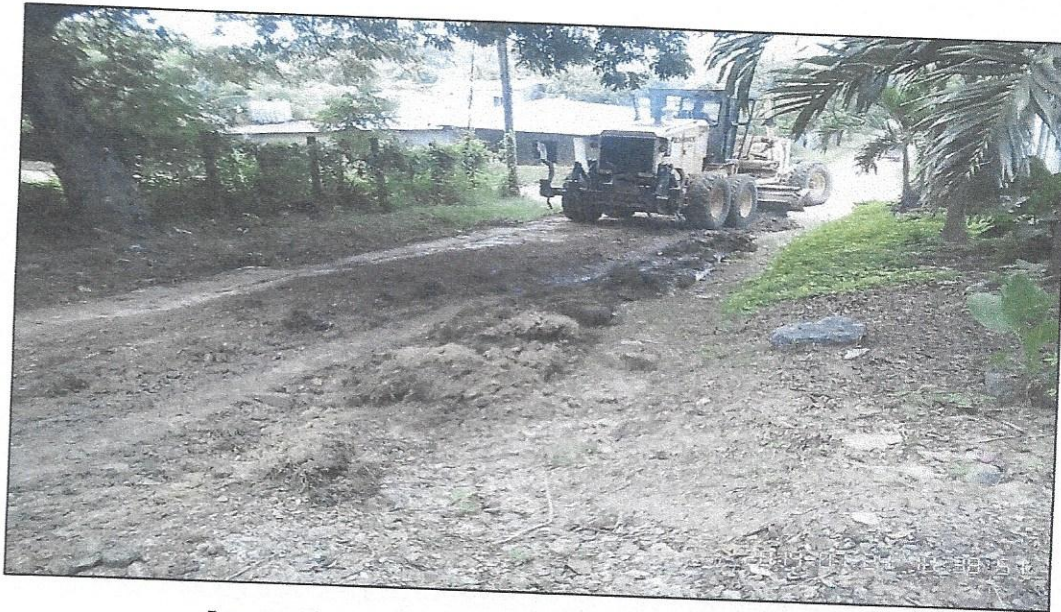
Reparación de calles Colonia Orquídea I, Sector Oeste B
