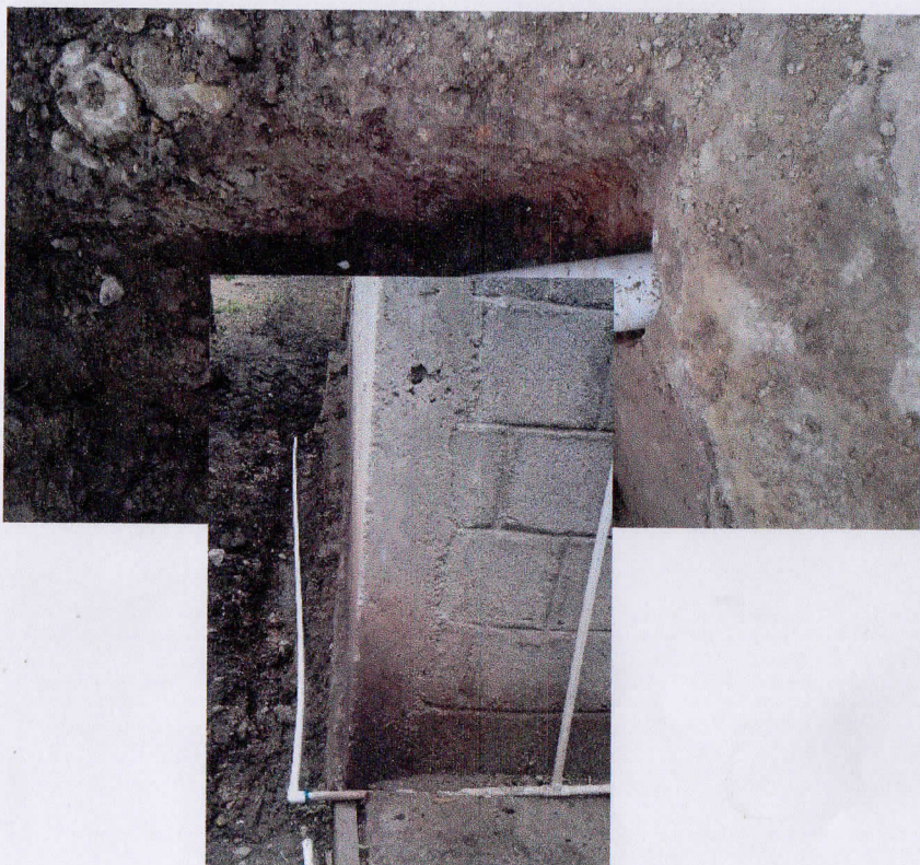
Reparación de tubería
