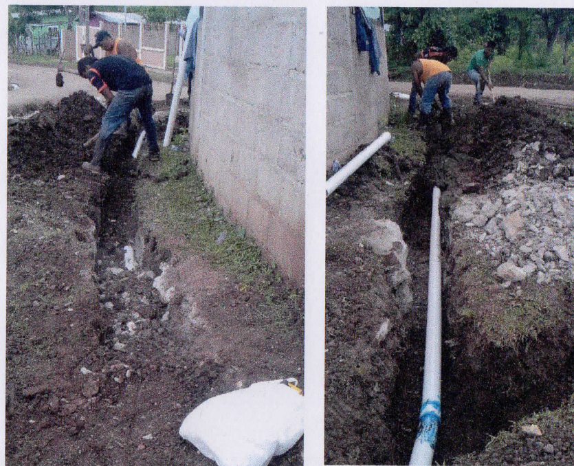
Aquí vemos lo que es cambio de tuberías
