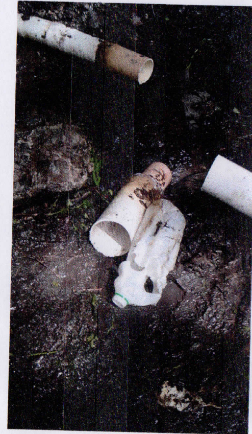
reparación en la represa
