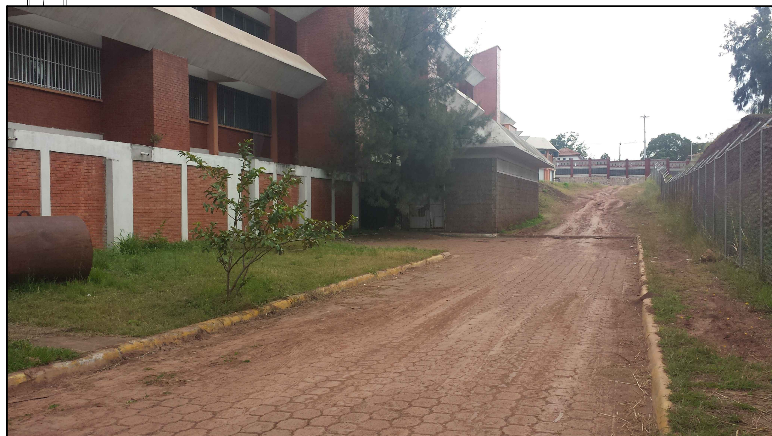
2 FOTOGRAFÍA DE UBICACIÓN - ÁREA DE BODEGAS Y ALMACENAMIENTO
