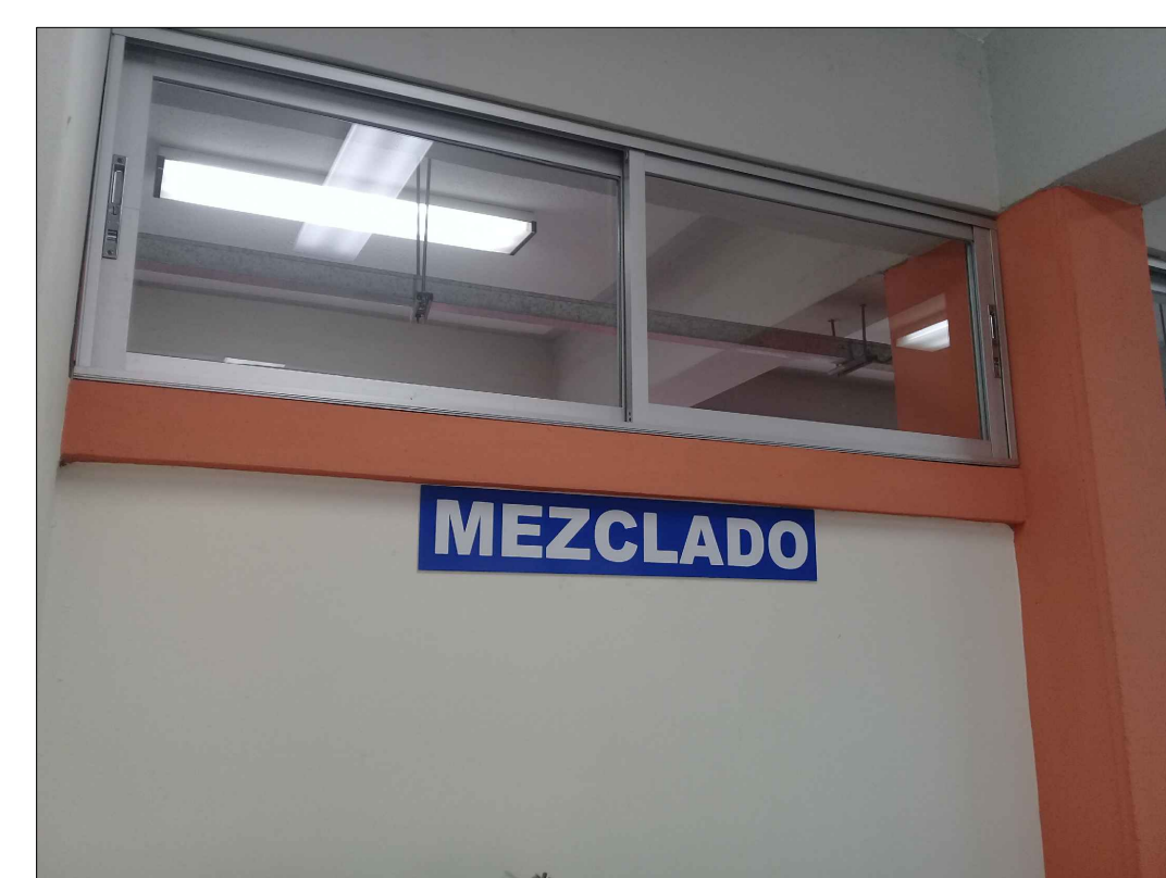
3 FOTOGRAFÍA DE VENTANA EXISTENTE A SER MODIFICADA POR PASO DE TUBERÍA
