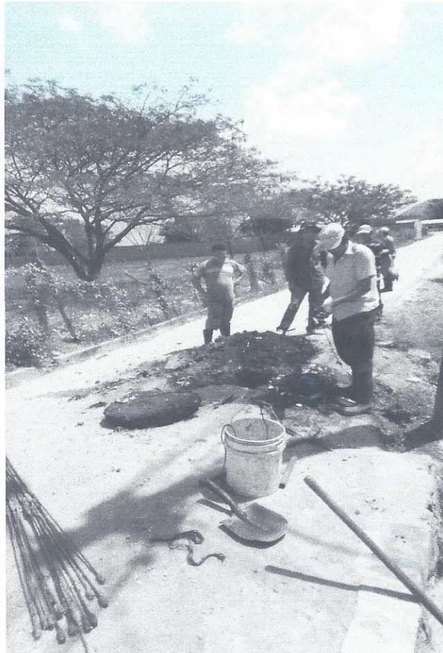
13. Realizando conexiones de Alcantarillado Sanitario en diferentes zonas.
