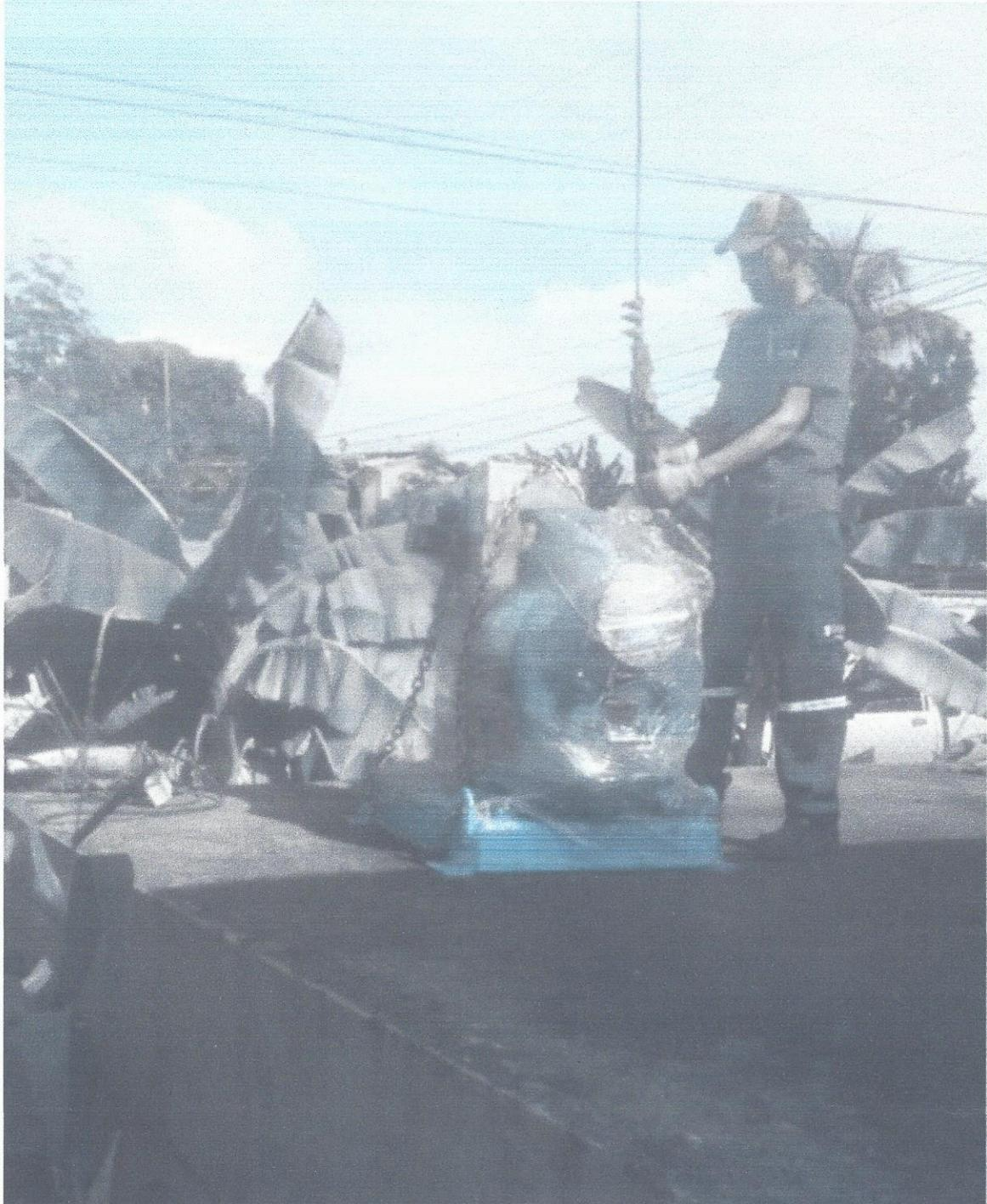
7. Empalme y medición en instalación de equipo sumergible de 7.5 HP en el Pozo El Calan.
