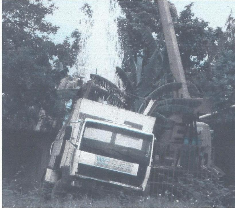
7. Extracción de equipo sumergible del Pozo Cañeras #2, cambio de bomba de 75 HP
