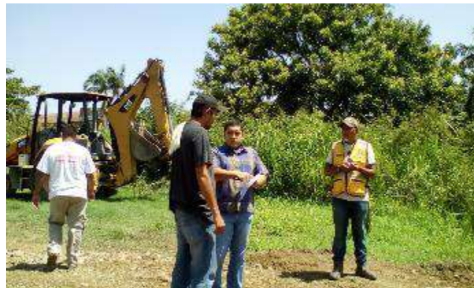
Apertura de calle Barrio Camagüey
