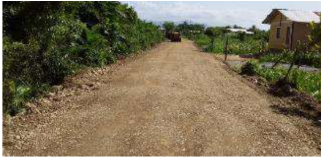
Apertura de calle en la col. Nuevos horizontes
