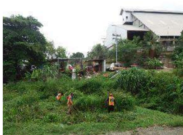
Limpeza de la quebrada el pato de la Col. 9 de diciembre, Sector Medina
