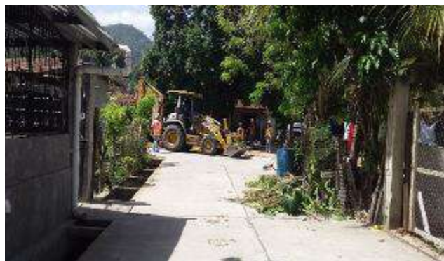
Limpeza de canales en la comunidad del Triunfo, Sector Puente Alto
