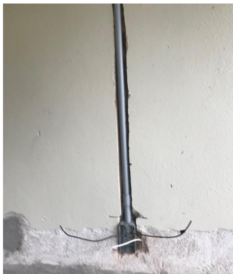
Instalación de tomacorrientes
