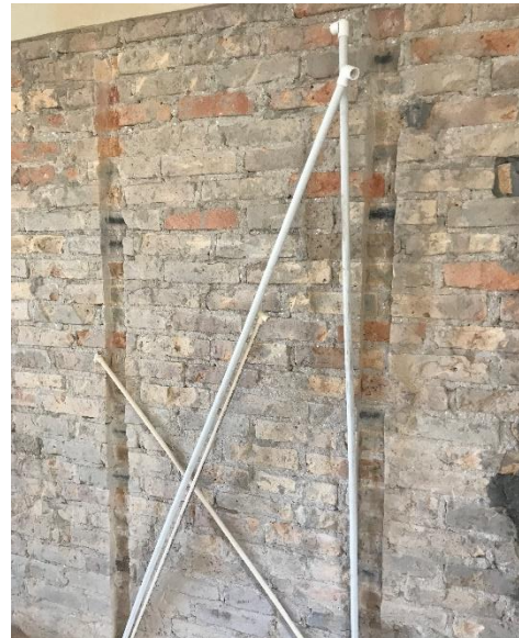
Ranurado en paredes
