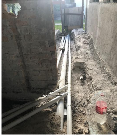
Instalación de tubería 2 "pvc para duchas
