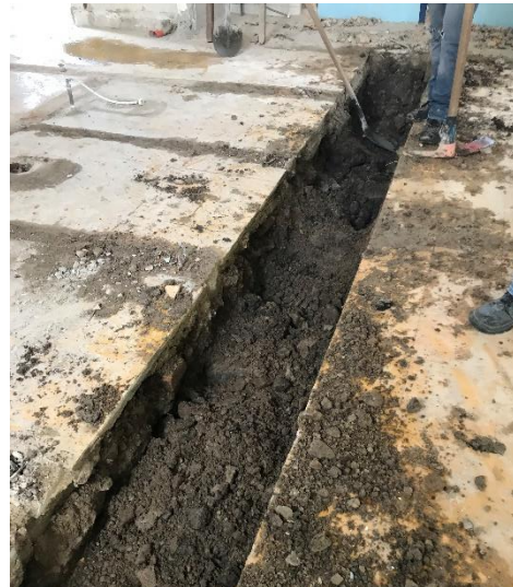
Acarreo de material de Demoliciones
