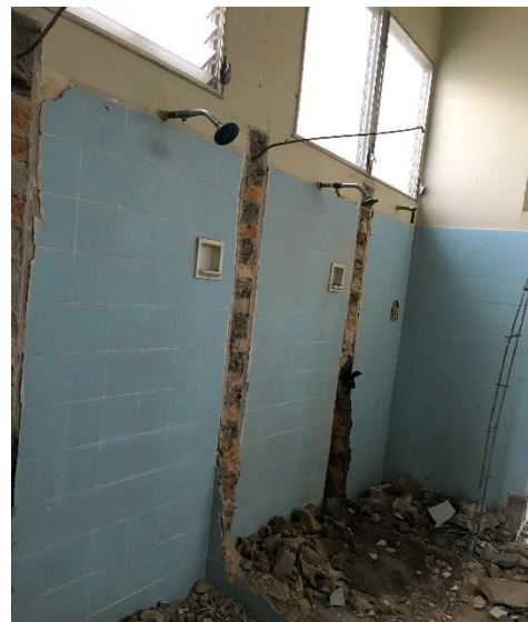
Demolición de Paredes de Duchas y azulejos
