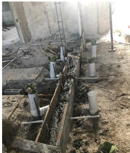
Colocación Material Selecto
