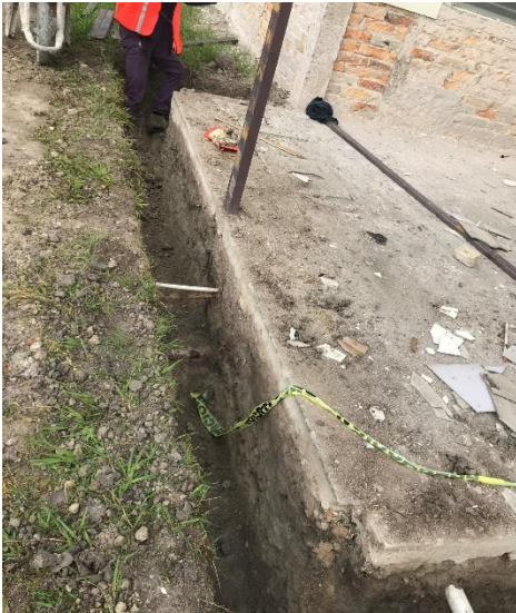
Acarreo de material de Demoliciones
