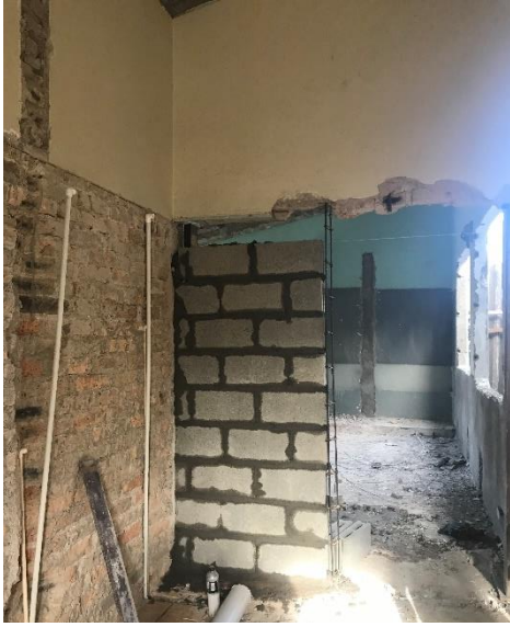
Pared de boquetes de puerta existente
