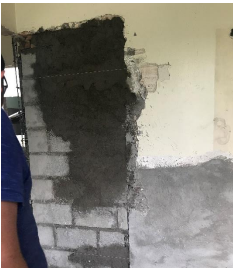
Repello de paredes
