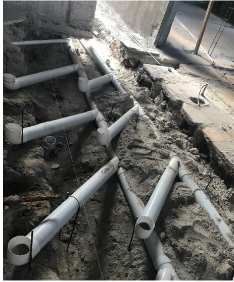
Instalación de tubería 4"pvc para duchas
