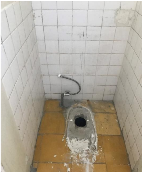
Desmontaje de sanitario
