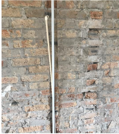
Instalación de tubería ½ cpvc para duchas
