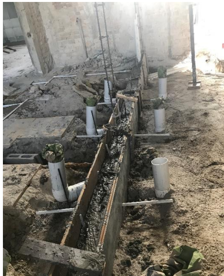
Zapata corrida fundida
