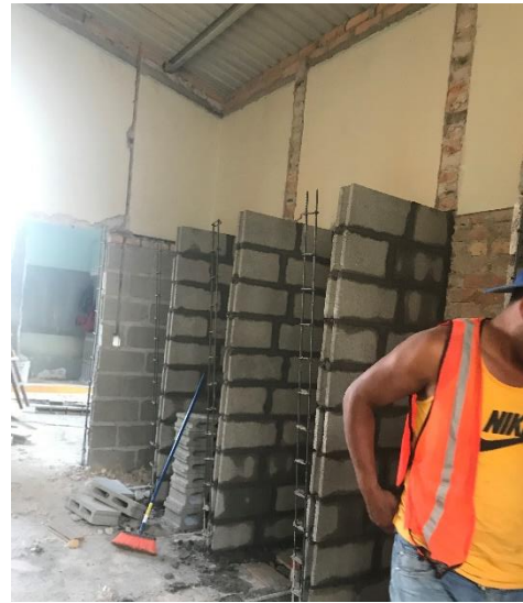
Pared división de Baños
