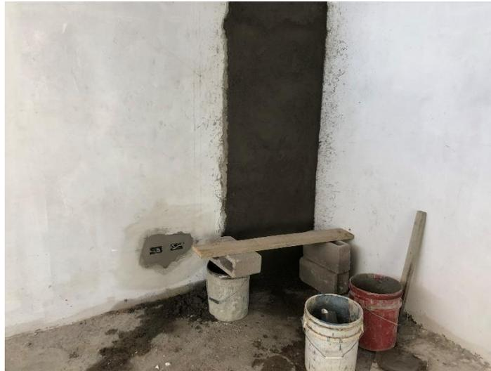
Imagen 18. Instalación de Tomacorrientes
