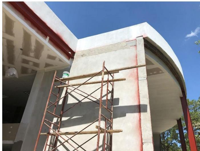
Imagen 8. Suministro e Instalación de Durock en Vigas Metálicas
