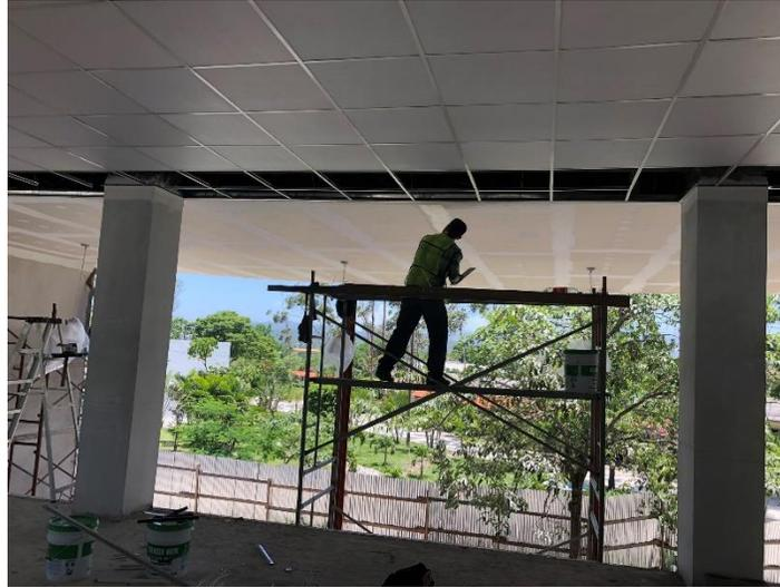
Imagen 4. Suministro e Instalación de Cielo Falso de Tabla yeso en Dobles Alturas
