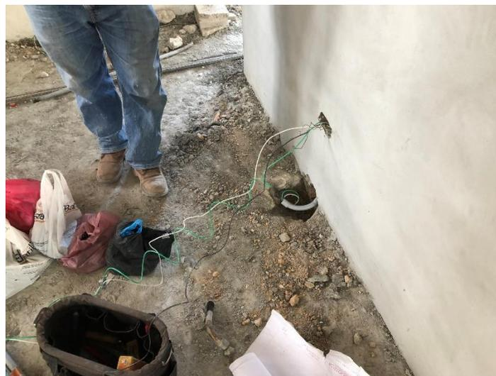
Imagen 17. Instalación de Tomacorrientes
