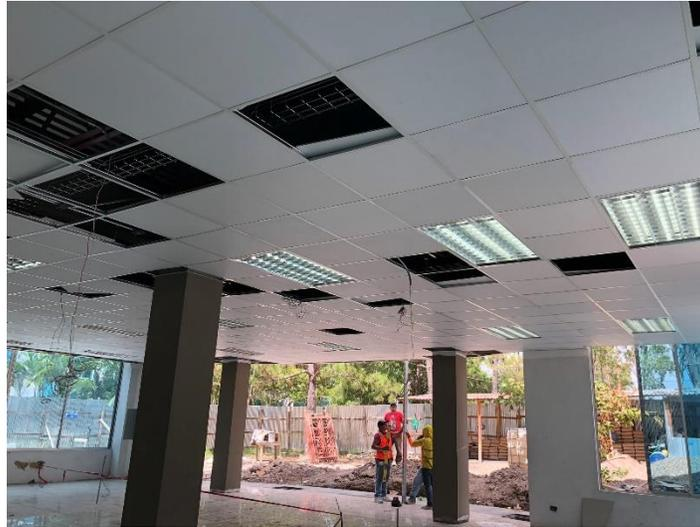
Imagen 2. Suministro e Instalación de Cielo Falso Acústico en Primer Nivel
