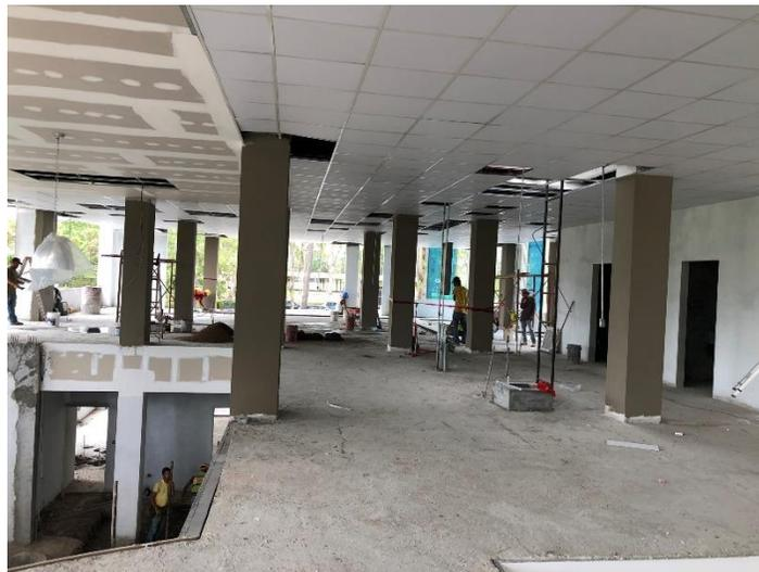
Imagen 1. Suministro e Instalación de Cielo Falso Acústico en Segundo Nivel
