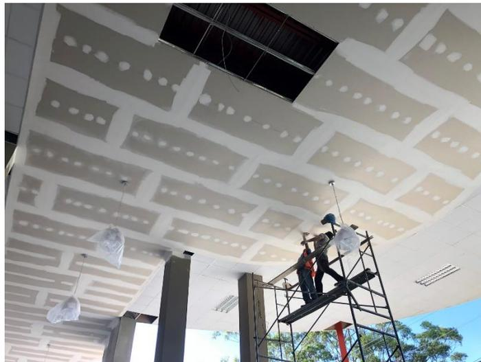
Imagen 3. Suministro e Instalación de Cielo Falso de Tabla yeso en Dobles Alturas
