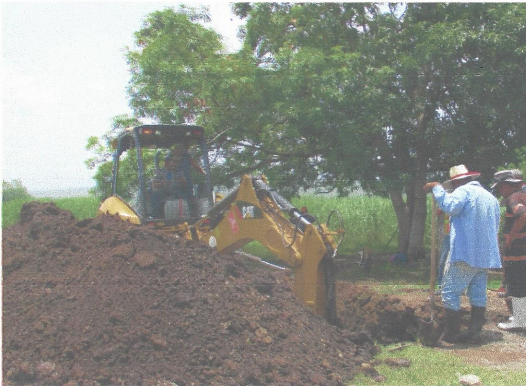
10. Reparación de tubería de impulsión de 8" en el Pozo #1, Zona Cañera.
