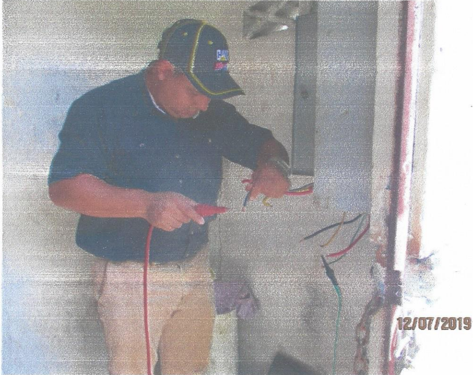
13. Conexión de Pozo #2, Zona Cañera.
