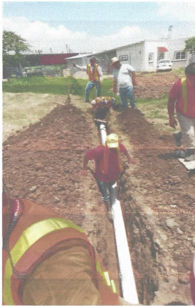
16. Conexión de Alcantarillado Sanitario en diferentes lugares.
