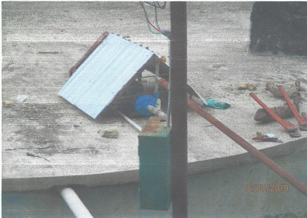
9. Instalación de bomba de 5HP en tanque Las Lomas.
