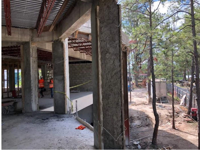
Imagen 6. Tallado de Columnas
