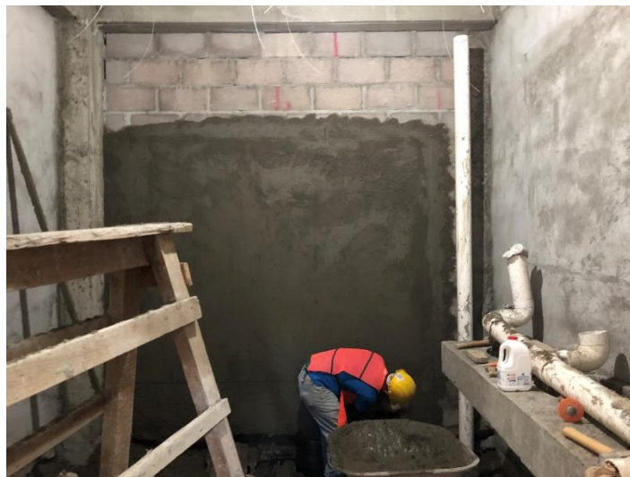
Imagen 8. Repello de Paredes
