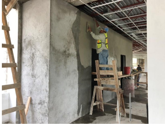
Imagen 11. Pulido de Paredes
