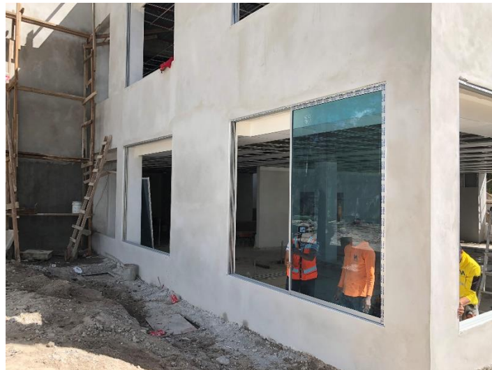
Imagen 20. Instalación de Ventanas Corredizas
