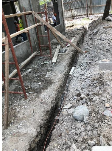
Imagen 18. Instalación de Red de Tierra
