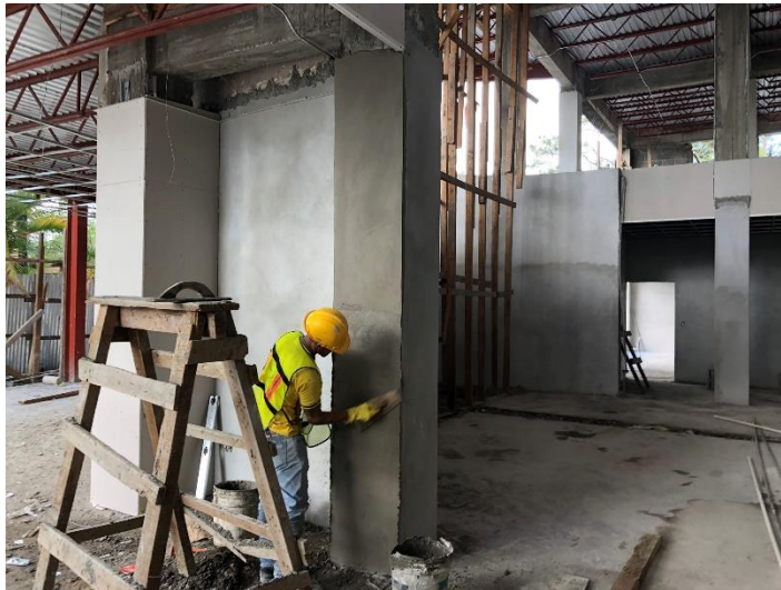
Imagen 7. Pulido de Columnas
