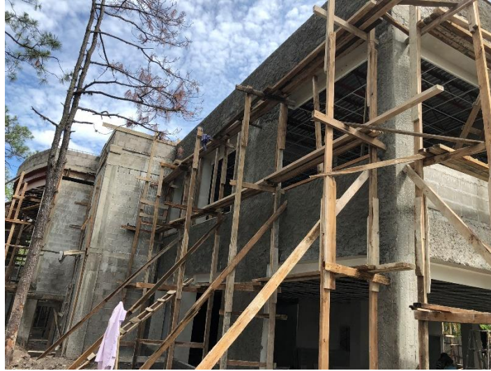
Imagen 9. Repello de Paredes
