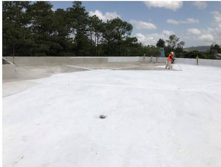
Imagen 15. Impermeabilización de Losa de Azotea
