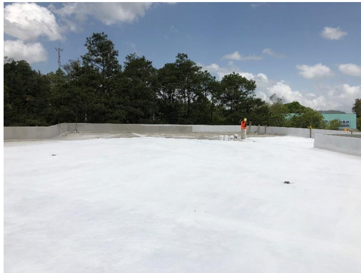
Imagen 16. Impermeabilización de Losa de Azotea
