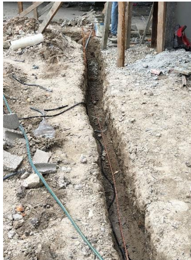
Imagen 17. Instalación de Red de Tierra
