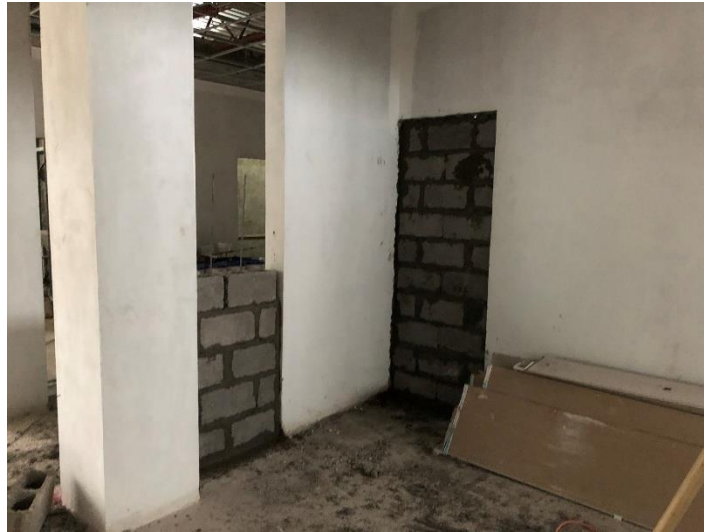
Imagen 1. Levantamiento de Paredes de Bloque
