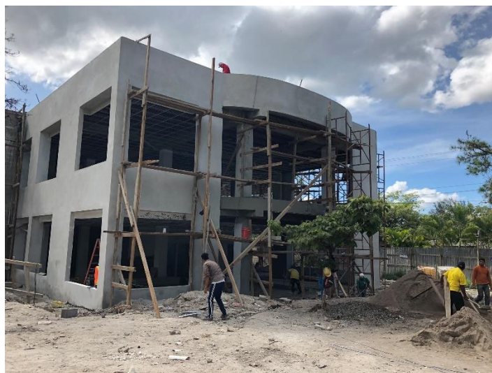
Imagen 10. Pulido de Paredes
