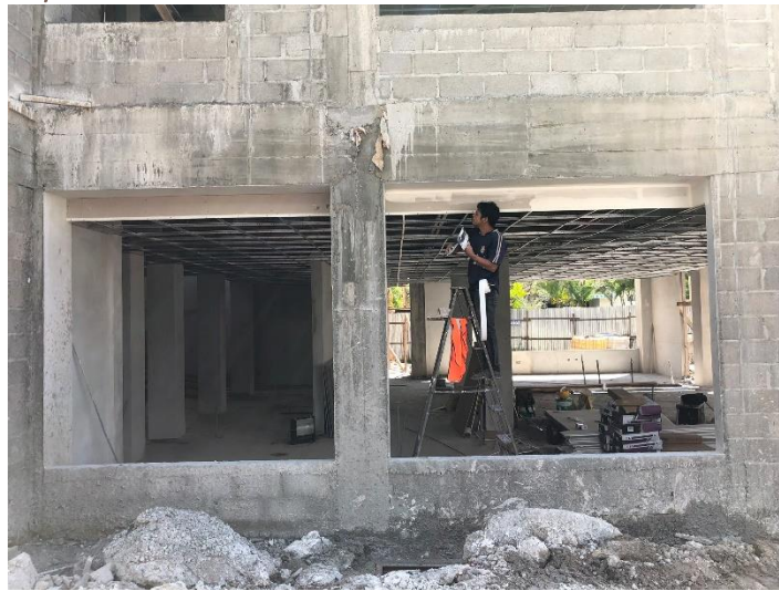
Imagen 13. Suministro e Instalación de Fascia en Ventanas
