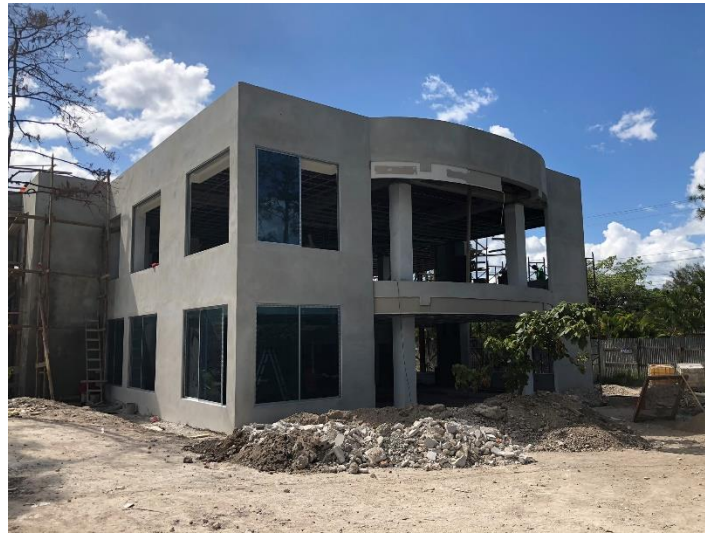
Imagen 19. Instalación de Ventanas Corredizas
