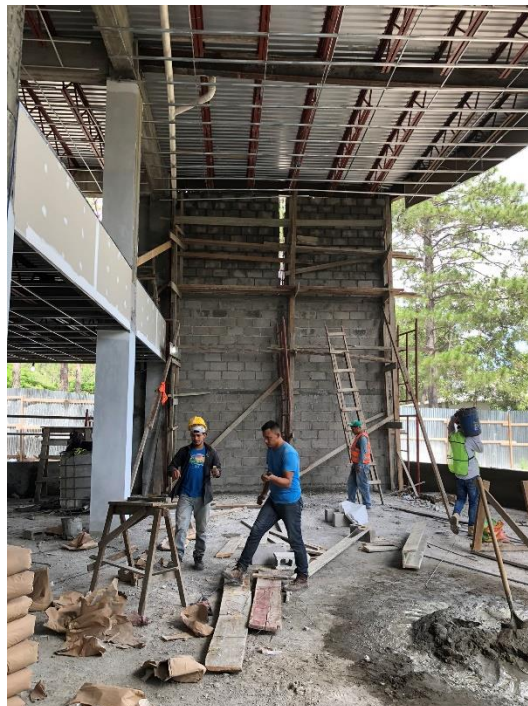
Imagen 2. Levantamiento de Paredes de Bloque
