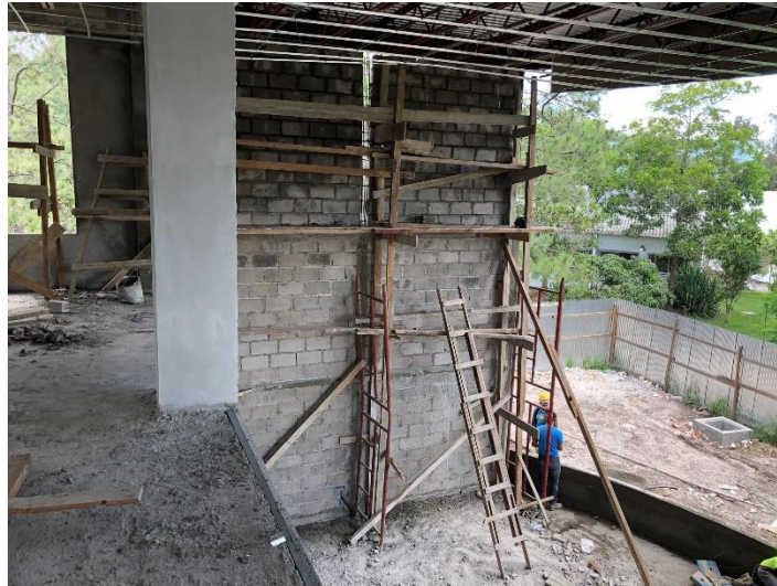
Imagen 5. Fundición de Castillos y Soleras
