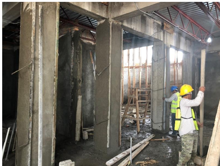
Imagen 13. Tallado de Elementos de Concreto
