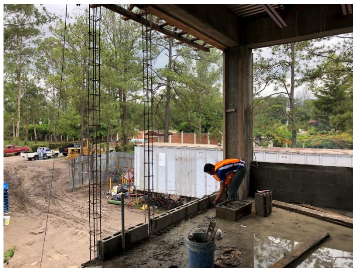
Imagen 5. Armado de Castillos
