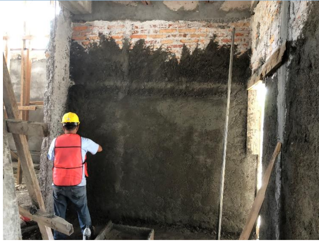
Imagen 15. Repello de Paredes
