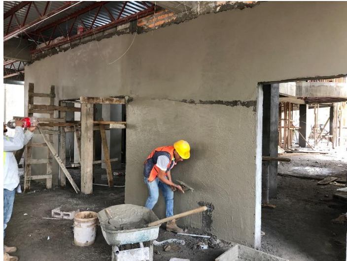
Imagen 18. Pulido de Paredes
