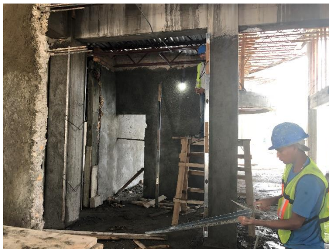
Imagen 17. Repello de Paredes
