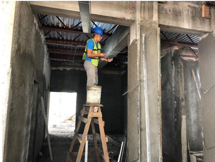
Imagen 12. Tallado de Elementos de Concreto
