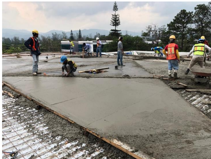
Imagen 7. Fundición de Losa de Azotea
