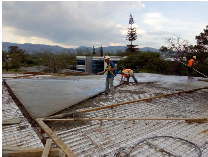
Imagen 8. Fundición de Losa de Azotea
