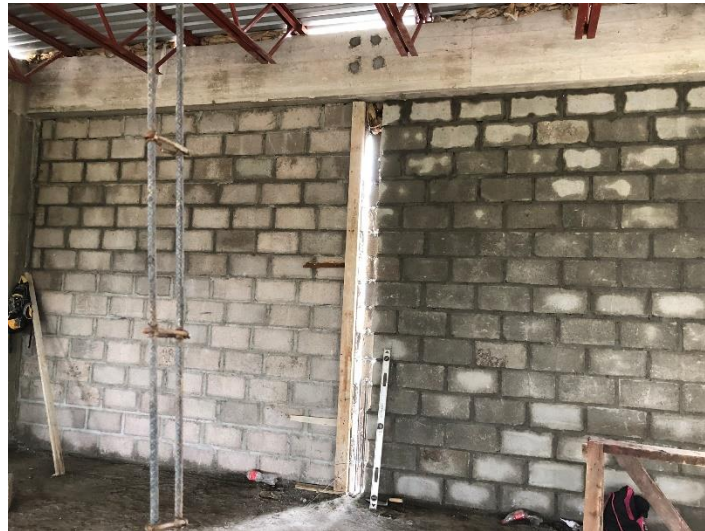
Imagen 1. Levantamiento de Paredes de Bloque
