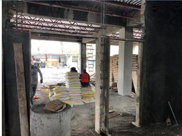
Imagen 3. Armado de Castillos
