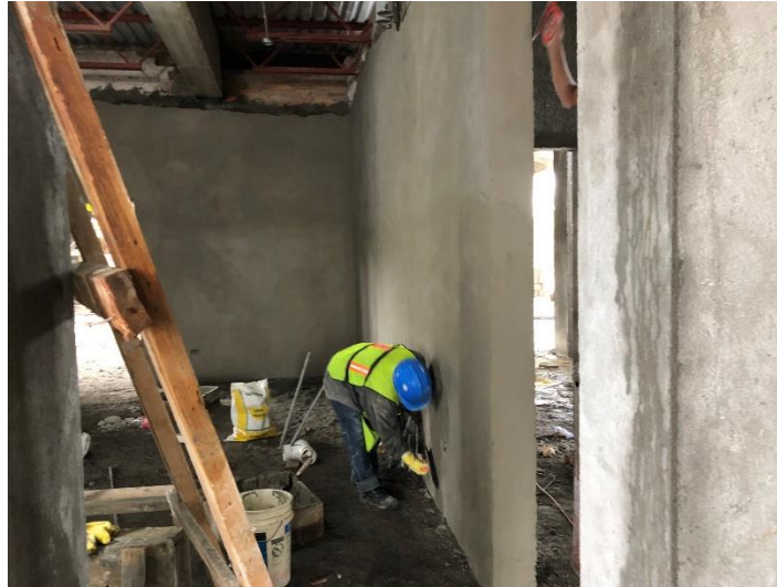
Imagen 20. Pulido de Paredes
