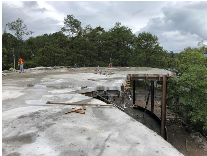
Imagen 6. Losa de Azotea
