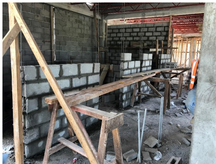
Imagen 2. Levantamiento de Paredes de Bloque
