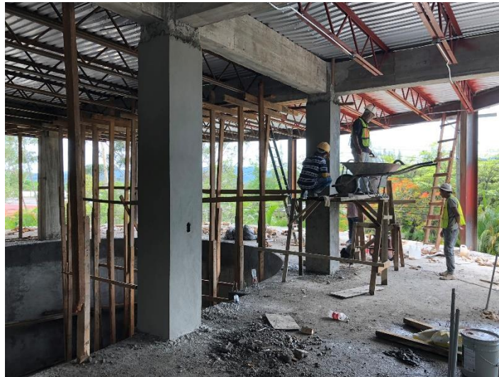
Imagen 14. Pulido de Elementos de Concreto
