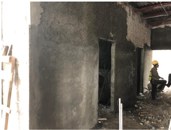
Imagen 16. Repello de Paredes
