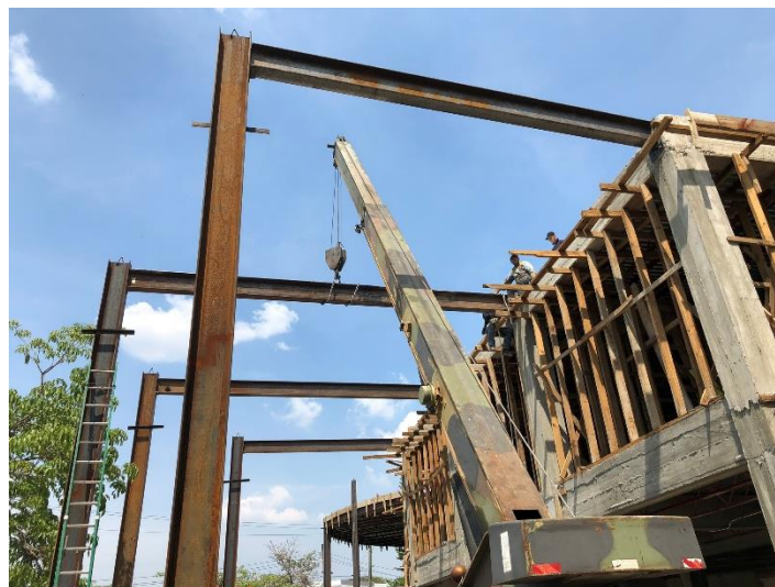
Imagen 9. Soldado Vigas Metálicas
