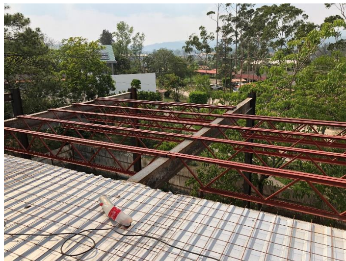
Imagen 11. Soldado y colocación de Joist sobre Vigas de Concreto
