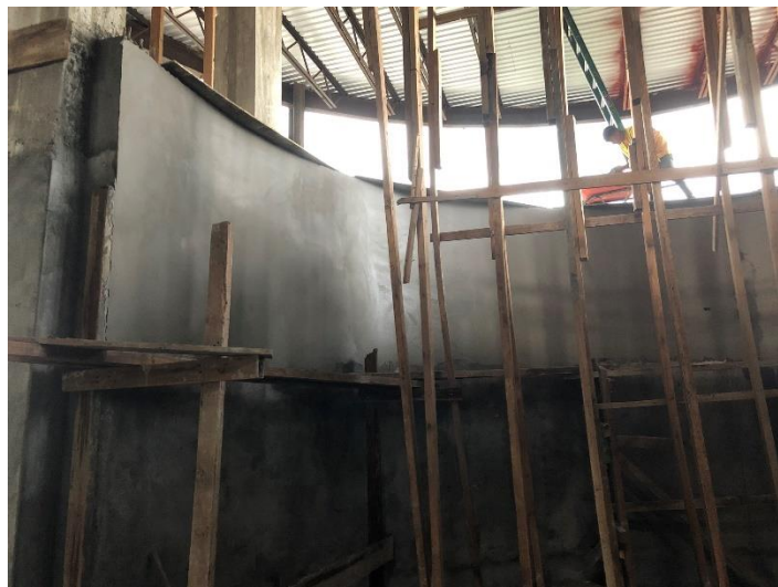
Imagen 19. Pulido de Paredes
