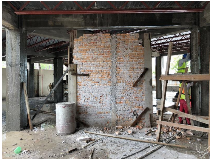
Imagen 4. Fundición de Castillos
