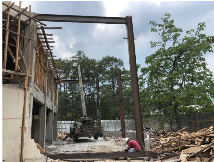
Imagen 10. Soldado Vigas Metálicas
