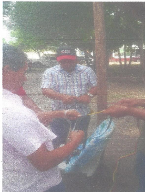
17. Empalmes e instalación en Pozo de Col. Monte Carmel.
