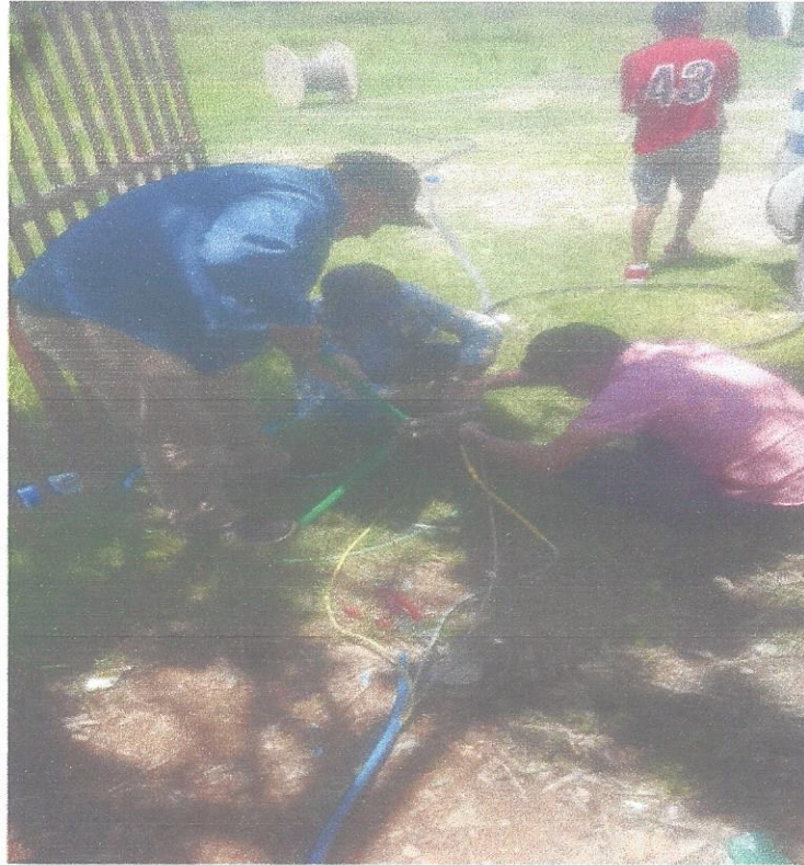
16. Empalmes e instalación de equipo en Pozo de Colinas de Suiza.
