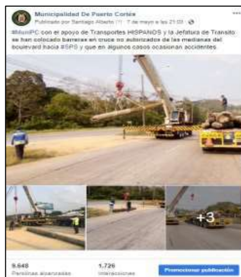
COLOCACIÓN DE BARRERAS EN CRUCES
