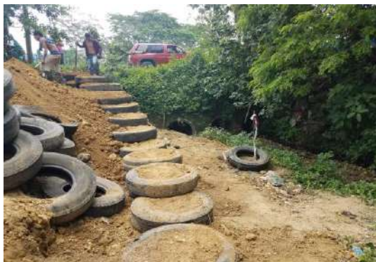
Estabilización de terreno en la comunidad de Casa Azul.
