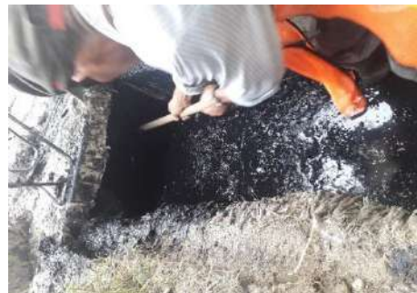
Limpieza de canales pluviales, B. El Porvenir Sector El Porvenir
