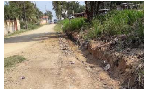
Apertura de canales naturales Col. Rio Mar, Sector El Porvenir
