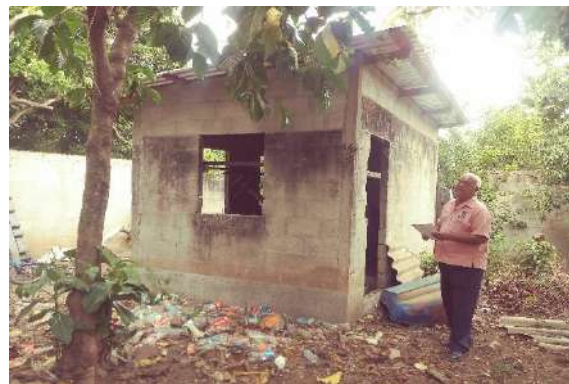
Santos Canales Alvarado Puente Alto
