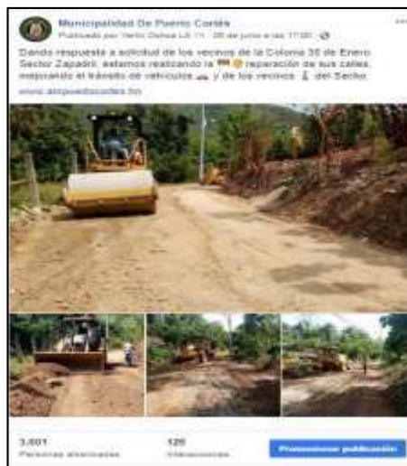
REPARACIÓN DE CALLES EN COL. 30 DE ENERO
