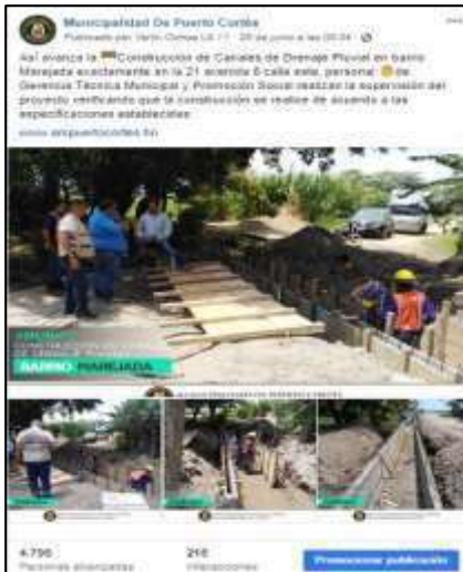
CONSTRUCCIÓN DE CANALES PLUVIALES EN BARRIO MAREJADA
