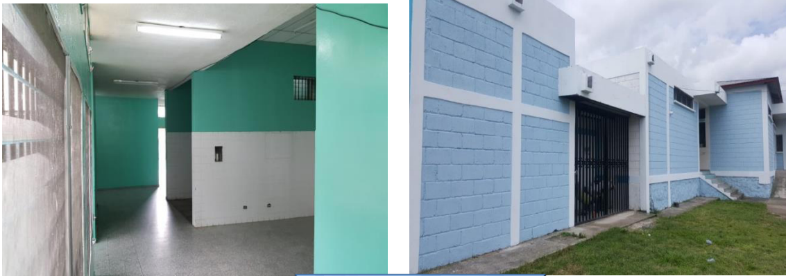
Obra terminada en Hospitalito
