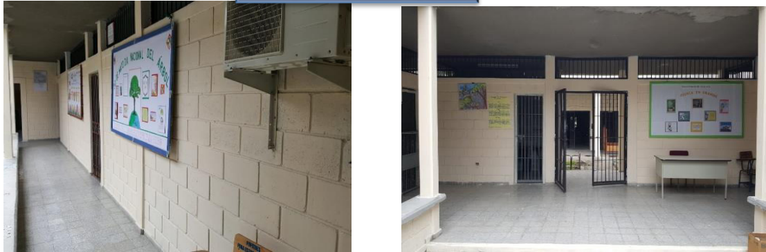
Colegio de Támara reparado
