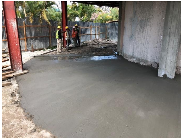
Imagen 3. Fundición de Firme de Concreto
