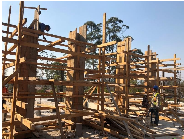
Imagen 5. Encofrado de Columnas
