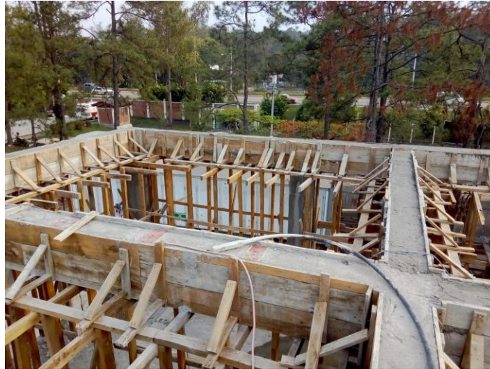
Imagen 7. Fundición de Vigas
