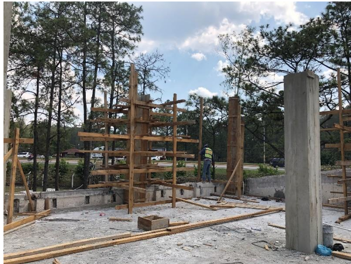
Imagen 6. Fundición de Columnas
