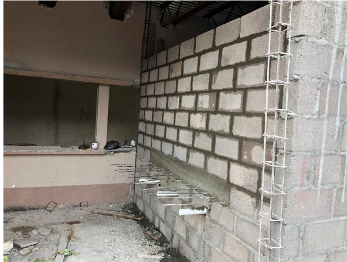
Imagen 1. Levantamiento de Paredes de Bloque
