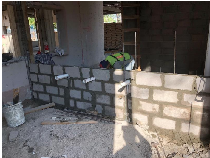
Imagen 2. Levantamiento de Paredes de Bloque
