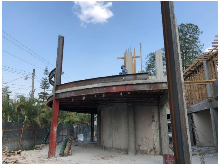
Imagen 10. Soldado y colocación de Joist sobre Vigas de Concreto
