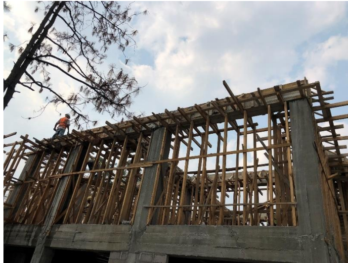
Imagen 8. Fundición de Vigas
