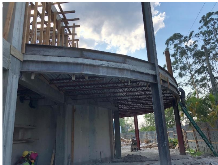
Imagen 9. Soldado Vigas Metálicas
