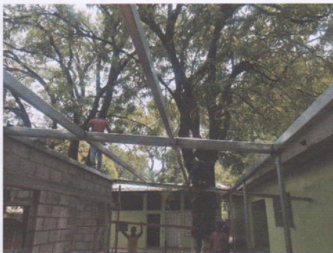
ESTRUCTURA DE TECHO, 26/04/2019
