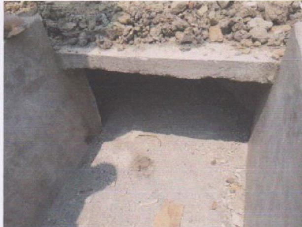
Aguas arriba, acceso. 26/04/2019
