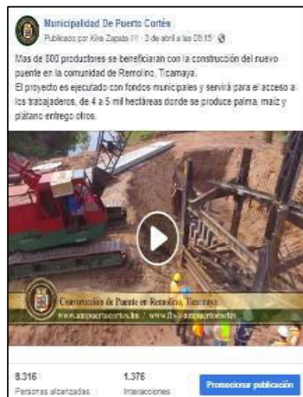
Avances de Construcción Puenete en Remolino Ticamaya
