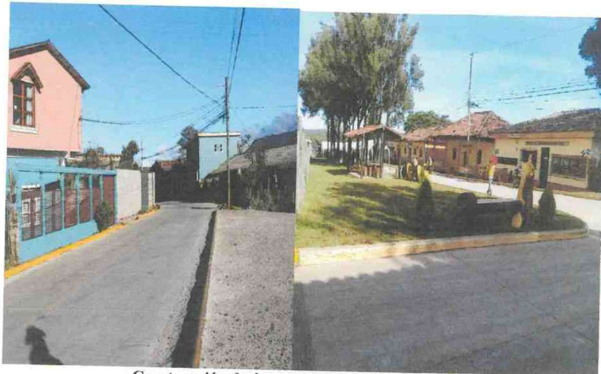
Construcción de áreas verdes en la calle saludable
