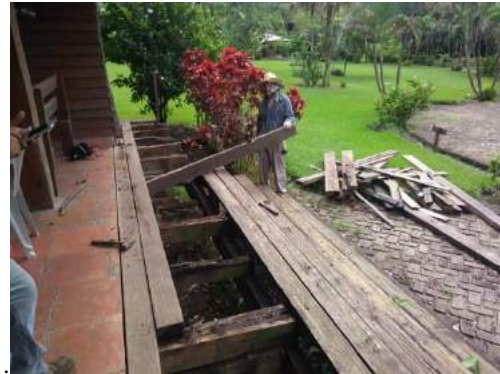
Reparación de accesos del centro de visitantes
