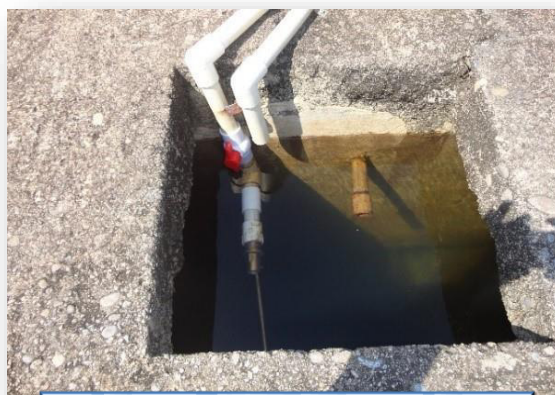
Instalación de bomba de tanque, C.P. de Nacaome
