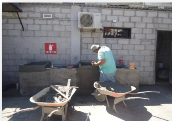
Remodelación del área de la cocina, C.P. de Gracias, Lempira
